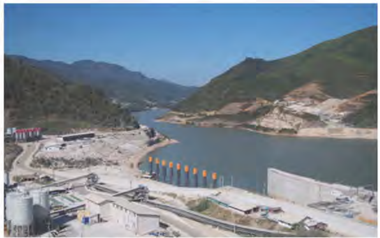
การก่อสร้างเขื่อนไซยะบุรีซึ่งใช้เถ้าลอยจากโรงไฟฟ้าแม่เมาะ จังหวัดลำปาง มาใช้ในการผสมคอนกรีต (ธิดารัตน์ พ.ศ.2559)
