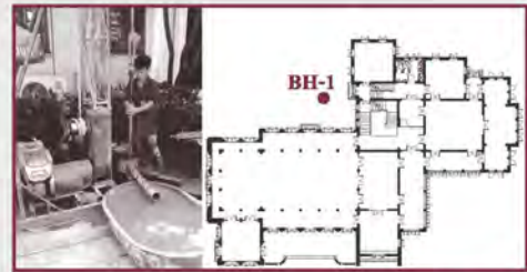
รูปที่ 9 ตำแหน่งเจาะสำรวจดินอยู่ใกล้กับฐานบ่อนอิสินธร
