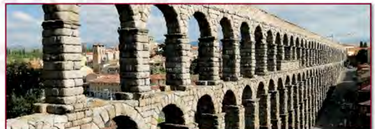
รูปที่ 5 Aqueduct of Segovia (ที่มา : http://www.camptocamp.org )
