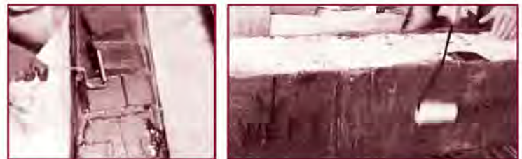
รูปที่ 4 คานคอนกรีต เสริมเหล็ก เสริมกำลังด้วยเส้นใยธรรมชาติ (Natural Fiber)
