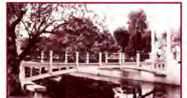
รูปที่ 5 สะพานปีกุน หรือ สะพานหนู
