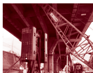
รูปที่ 1 เครื่องจักรก่อสร้างเสาเข็มเจาะแบบ (ก) กลม; (ข) เหลี่ยม; (ค) เหลี่ยมภายใต้ความสูงจำกัด
