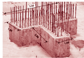
รูปที่ 2 เสาเข็มเจาะแบบ: (ก) กลม; (ข) เหลี่ยม; (ค) ตัว T; (ง) กากบาท
