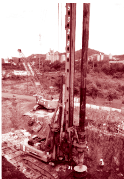
รูปที่ 1 เครื่องจักรก่อสร้างเสาเข็มเจาะแบบ (ก) กลม; (ข) เหลี่ยม; (ค) เหลี่ยมภายใต้ความสูงจำกัด
