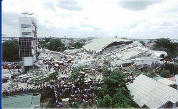
สาเหตุ : การต่อเติมอาคารโดยไม่ได้รับอนุญาต
