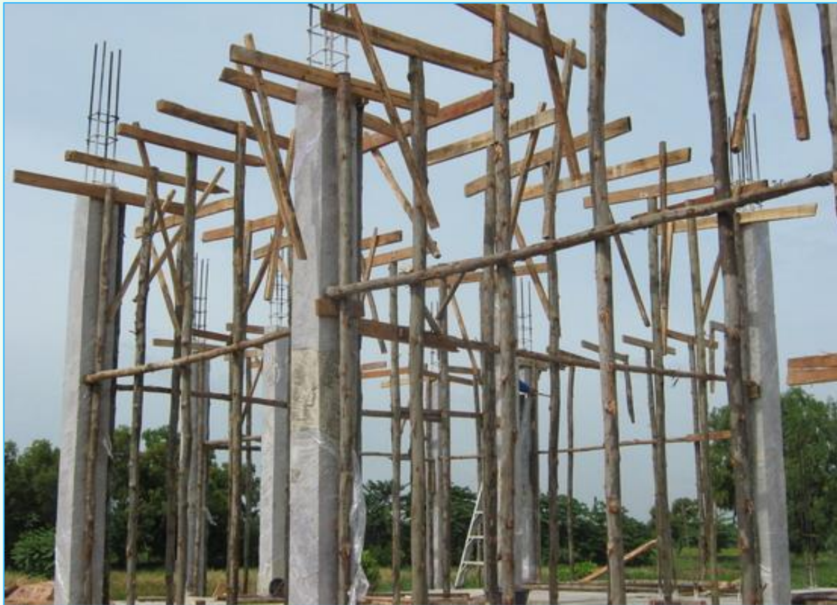
ภาพการก่อสร้างโครงสร้าง คสล. แบบแท็กซี่
