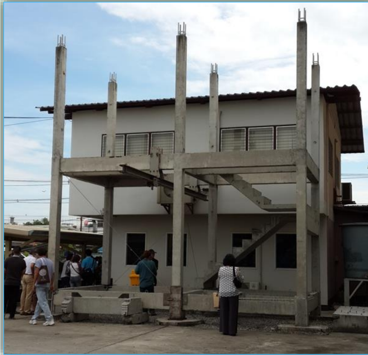
โครงสร้างสำเร็จรูปที่ประกอบแล้วเสร็จ
