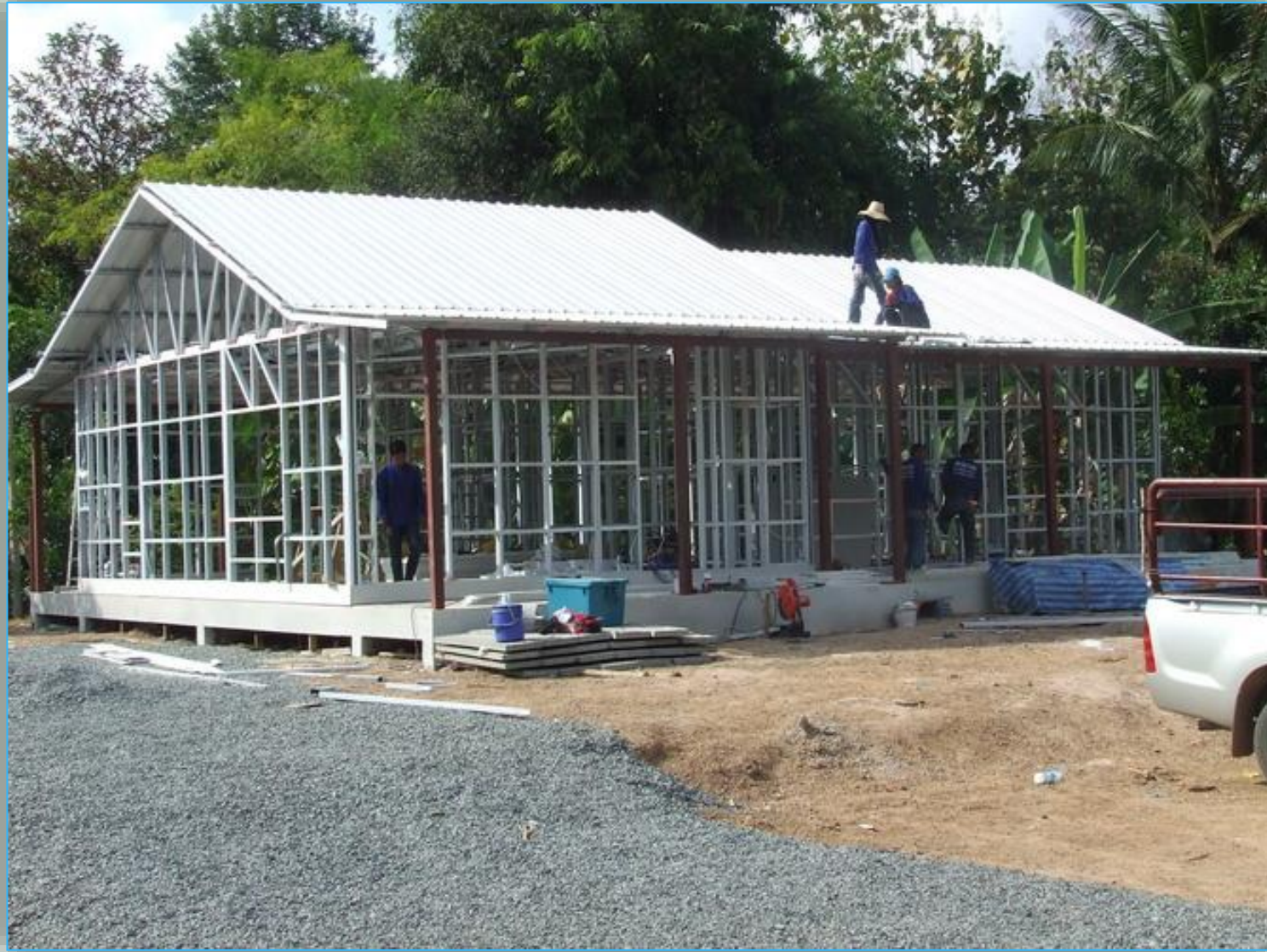
โครงสร้างอาคารเหล็ก
