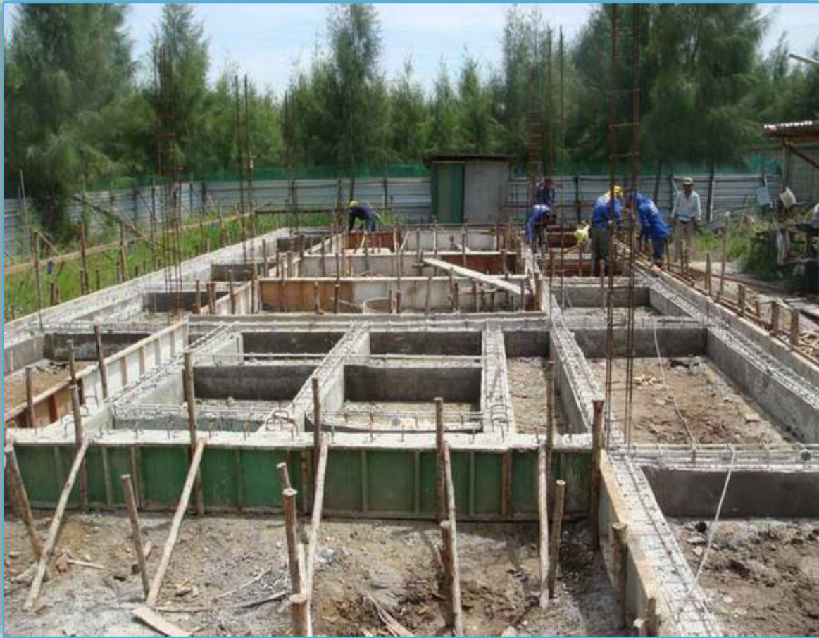
ภาพการก่อสร้างโครงสร้าง คสล. แบบเทกักบ่ที่
