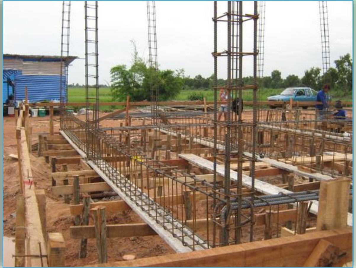
ภาพการก่อสร้างโครงสร้าง คสล. แบบเทกักบ่ที่
