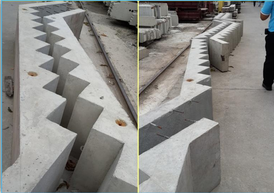
โครงสร้างสำเร็จรูปแบบหล่อแยกเป็นชั้นย่อย ๆ ยึดกันด้วยการเชื่อม แล้วเทหุ้มภายหลัง
