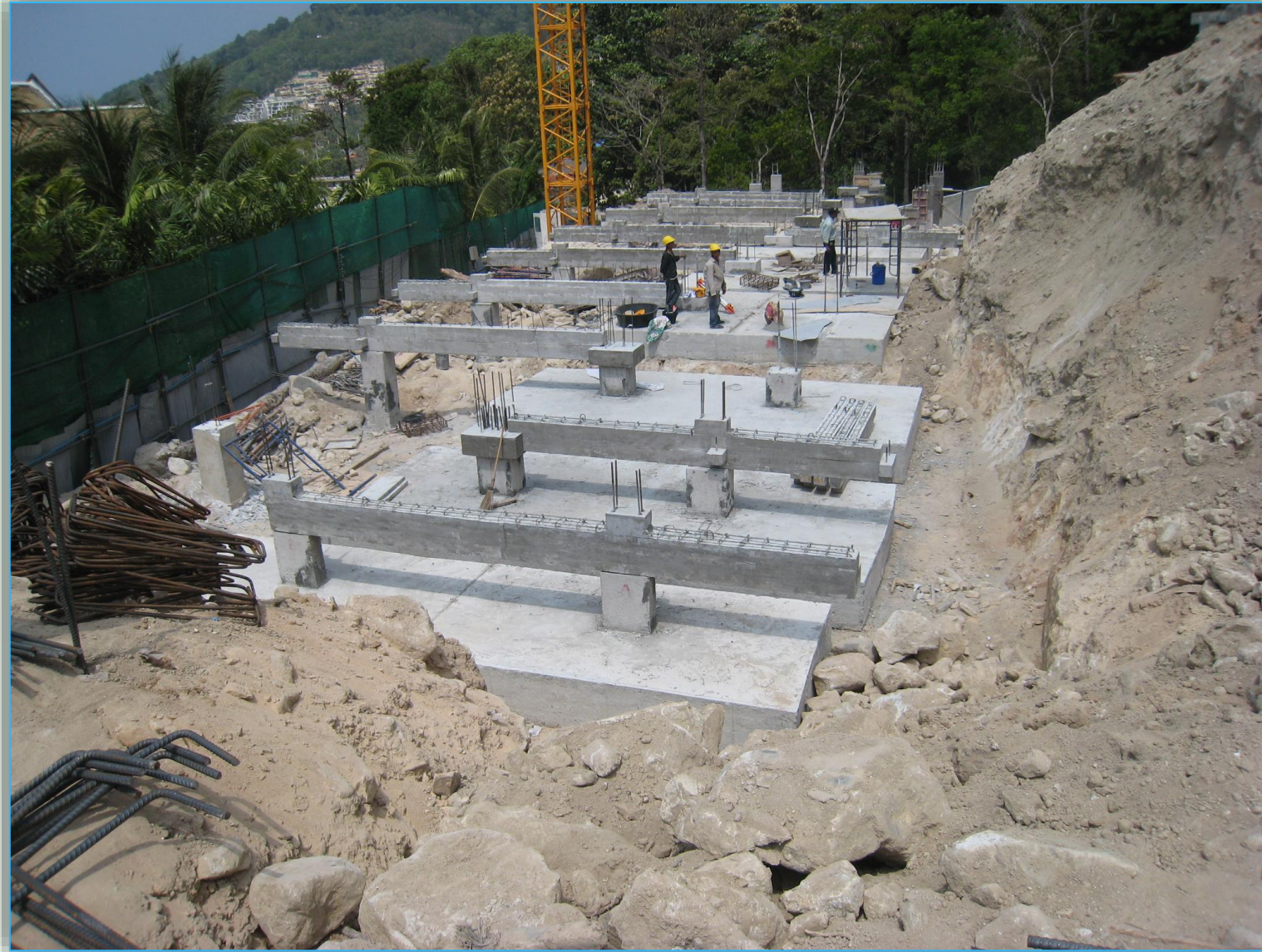
ภาพการติดตั้งคานสำเร็จชั้นล่าง
