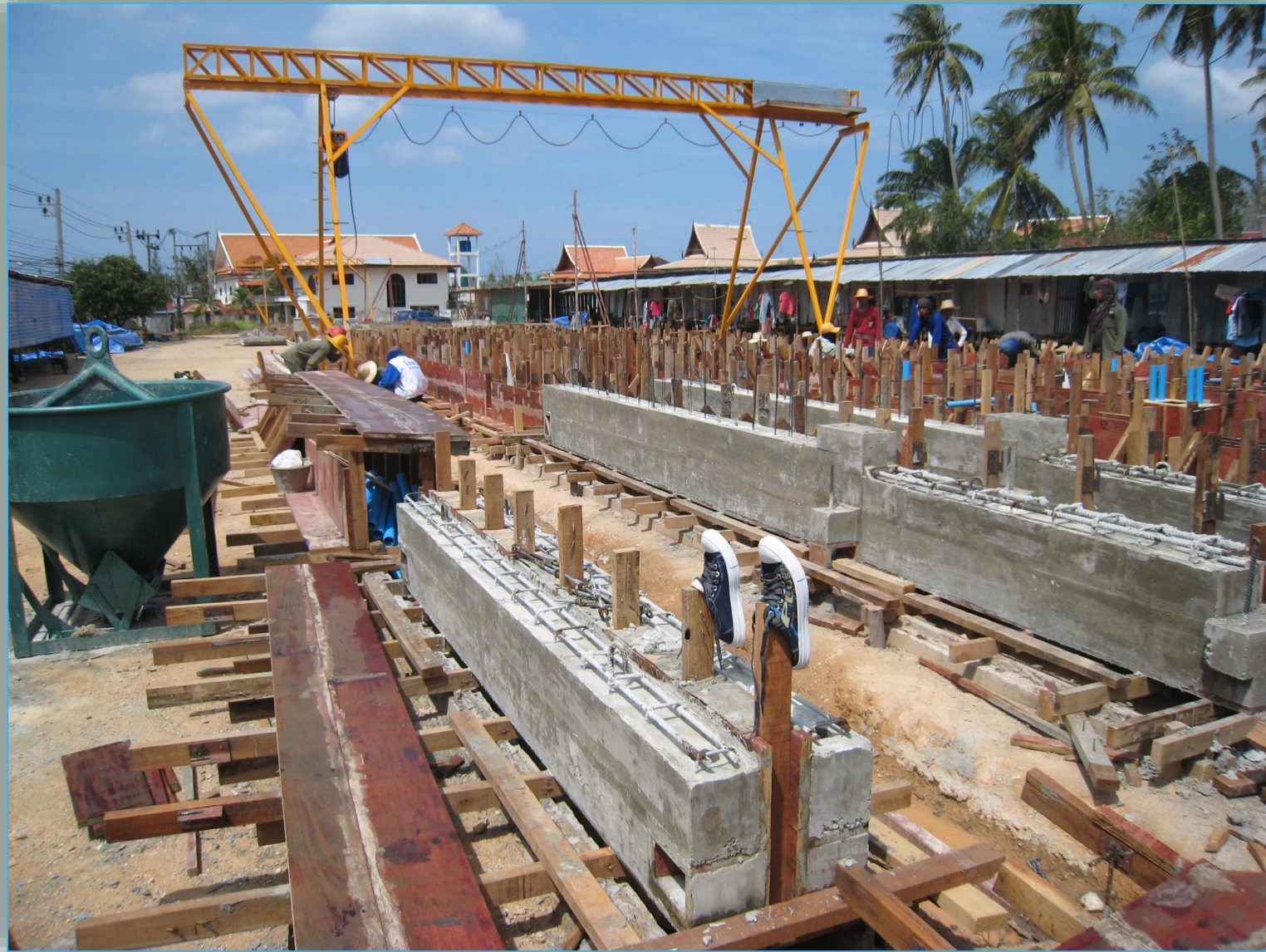
ภาพการหล่อชิ้นส่วนคานสำเร็จรูป
