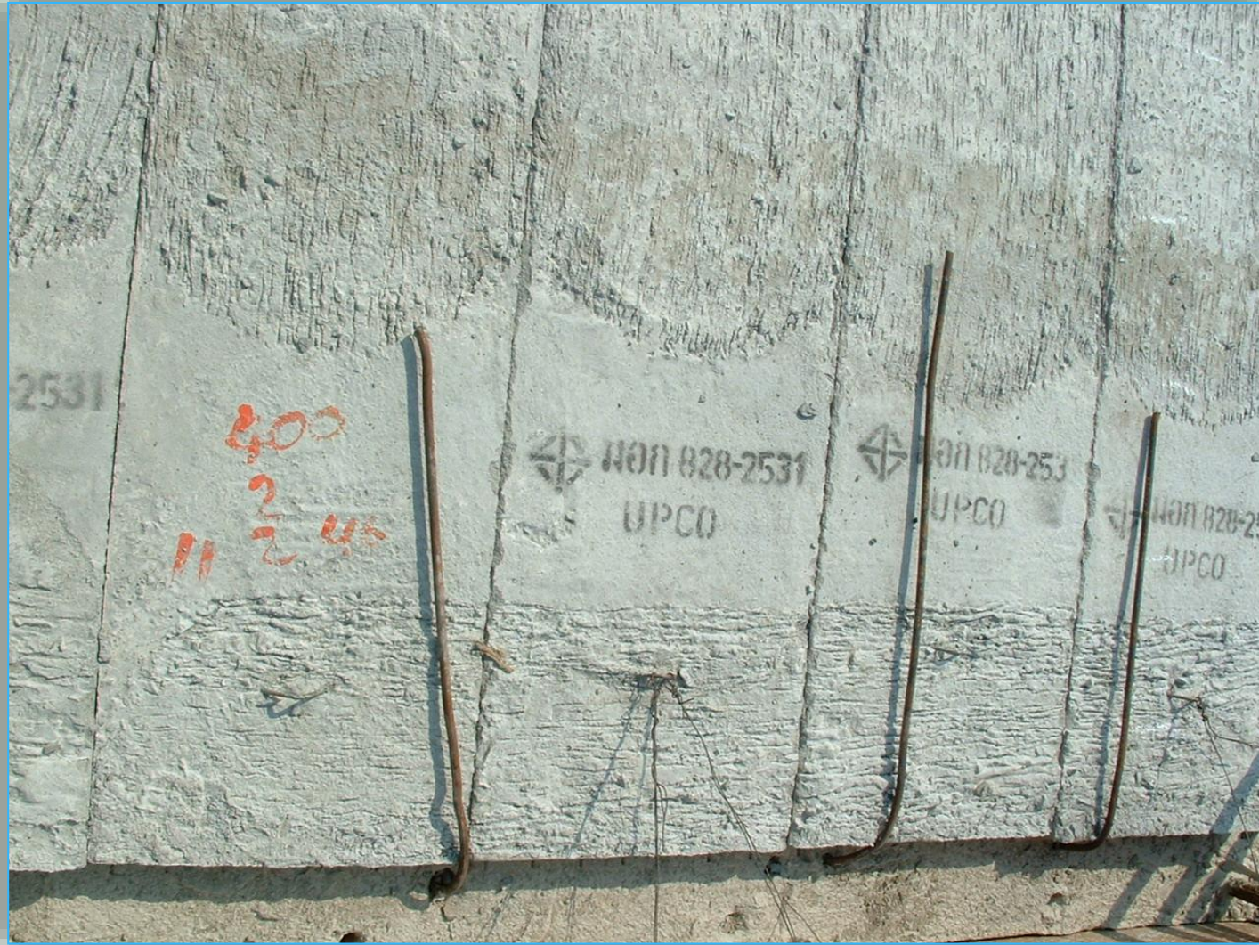
ภาพการติดตั้งพื้นสำเร็จแบบแผ่นกระดานเรียบ ซึ่งต้องมีการเสริมเหล็กเสริมพิเศษเพื่อรับ moment ที่แนวคาน
