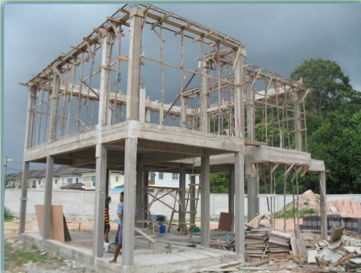
ภาพการก่อสร้างโครงสร้าง คสล. แบบเพกับที่
