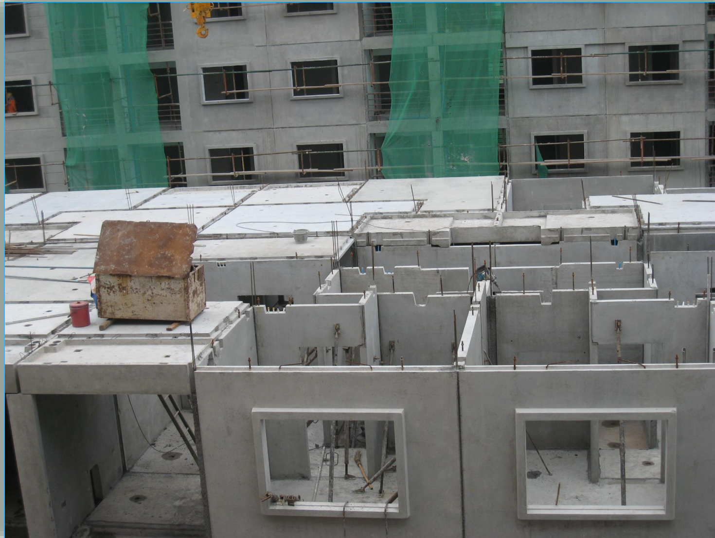
ภาพการติดตั้งชิ้นส่วนผนังและพื้น อาคารพักอาศัยสูง 8 ชั้น
