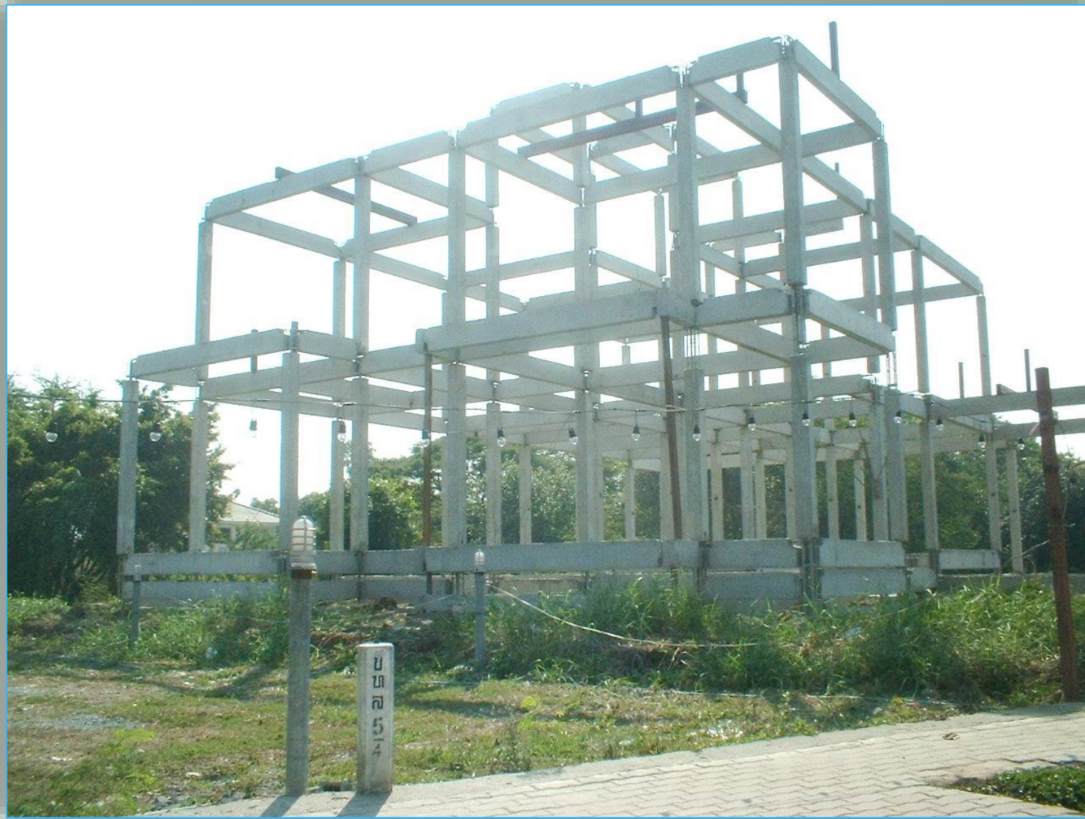
โครงสร้างสำเร็จรูปที่ประกอบแล้วเสร็จ
