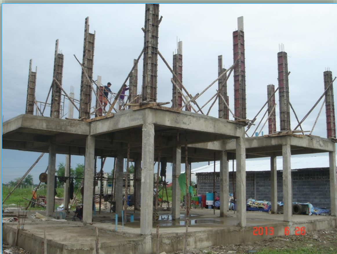
ภาพการก่อสร้างโครงสร้าง คสล. แบบเพกับที่
