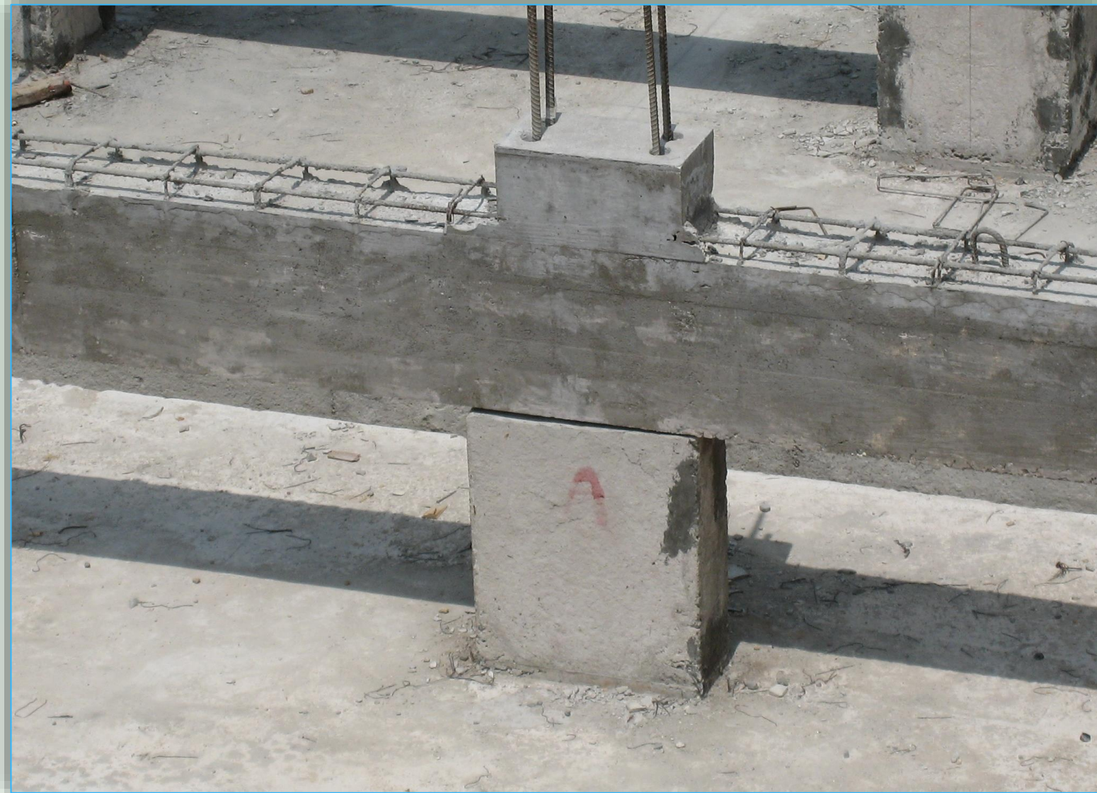
ภาพรอยต่อของคานกับเสาแบบยึดด้วย dowel
