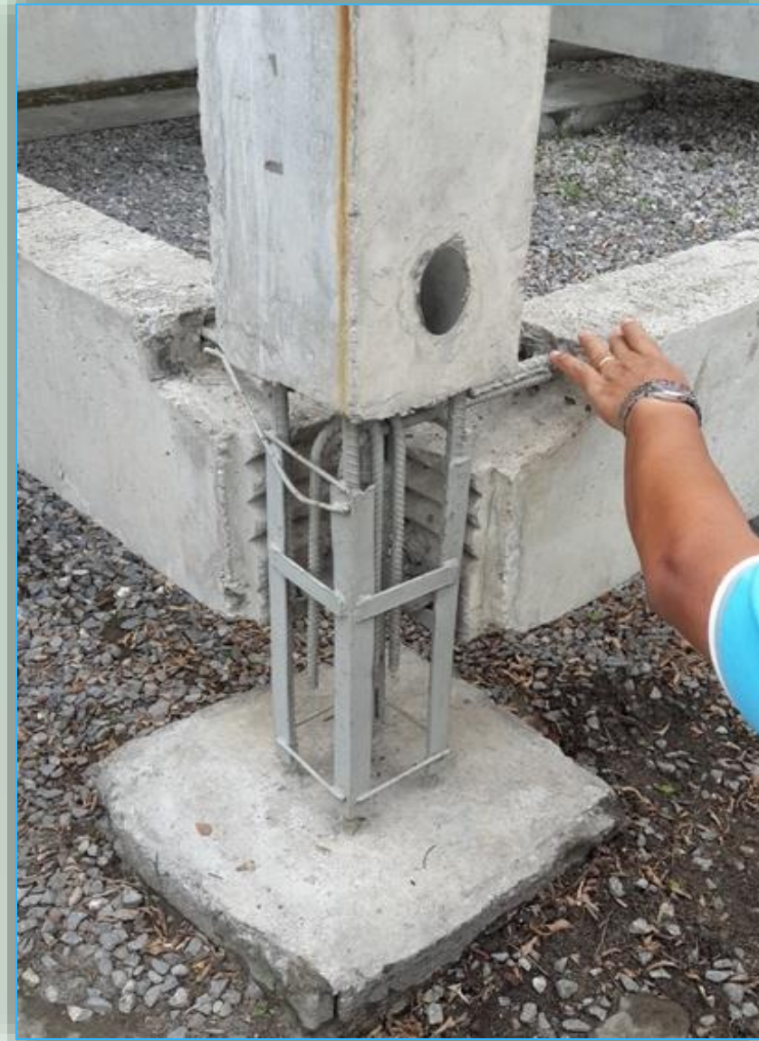
โครงสร้างสำเร็จรูปแบบหล่อแยกเป็นชั้นย่อย ๆ ยึดกันด้วยการเชื่อม แล้วเทหุ้มภายหลัง
