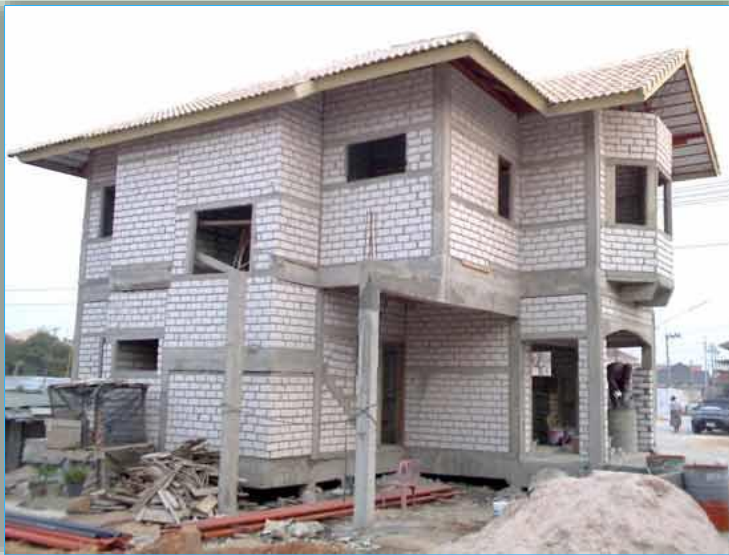
อาคารคอนกรีตเสริมเหล็ก ผนังอิฐบล็อก
