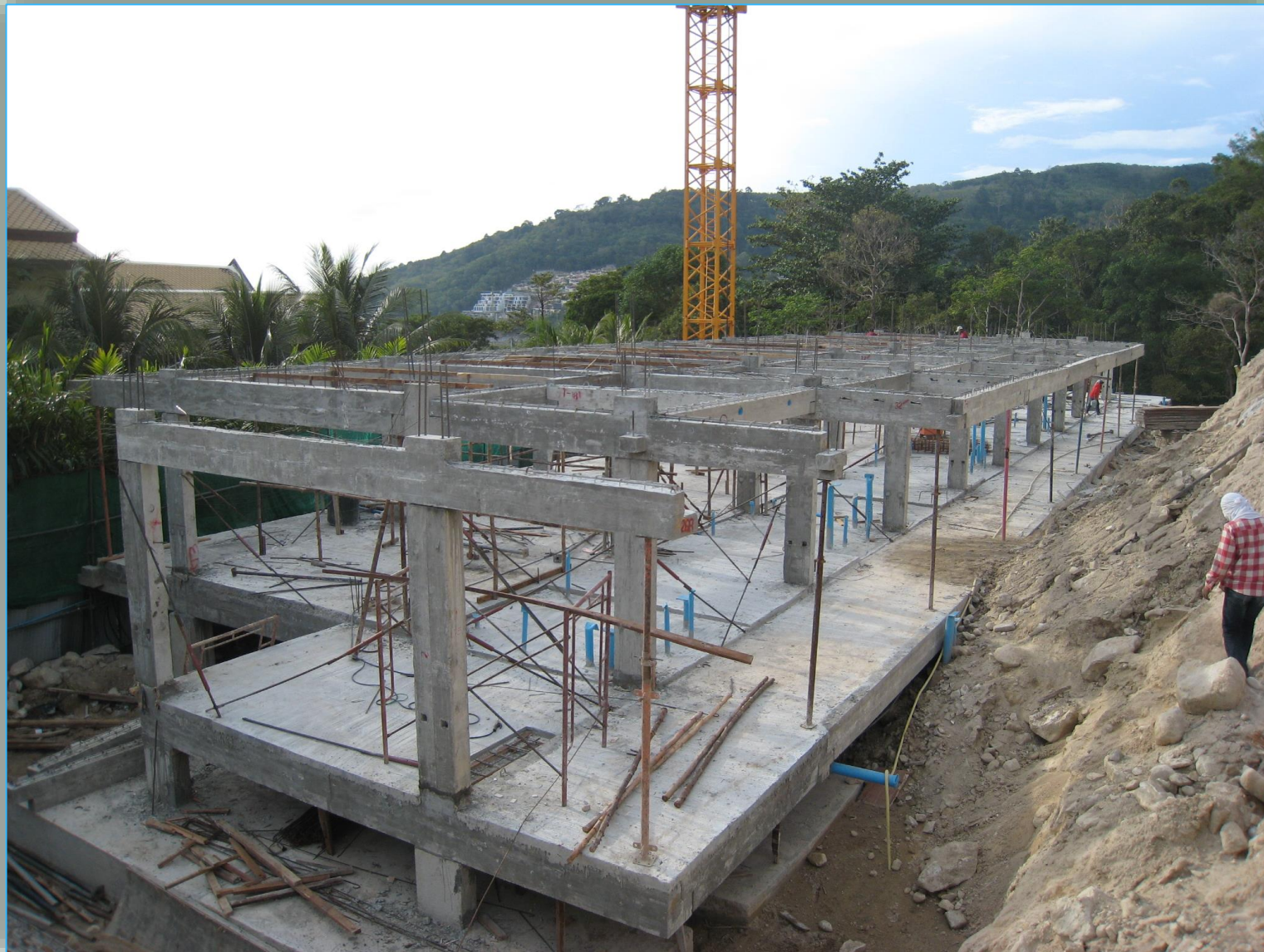
ภาพการติดตั้งเสาและคานชั้นสอง
