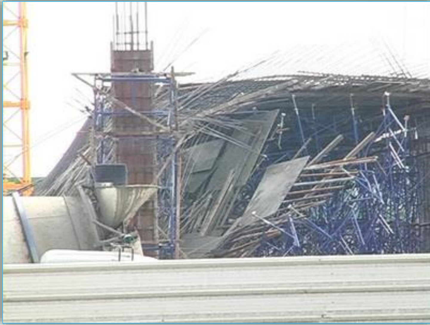
การพังทลายของอาคารในขณะที่เทคอนกรีต
