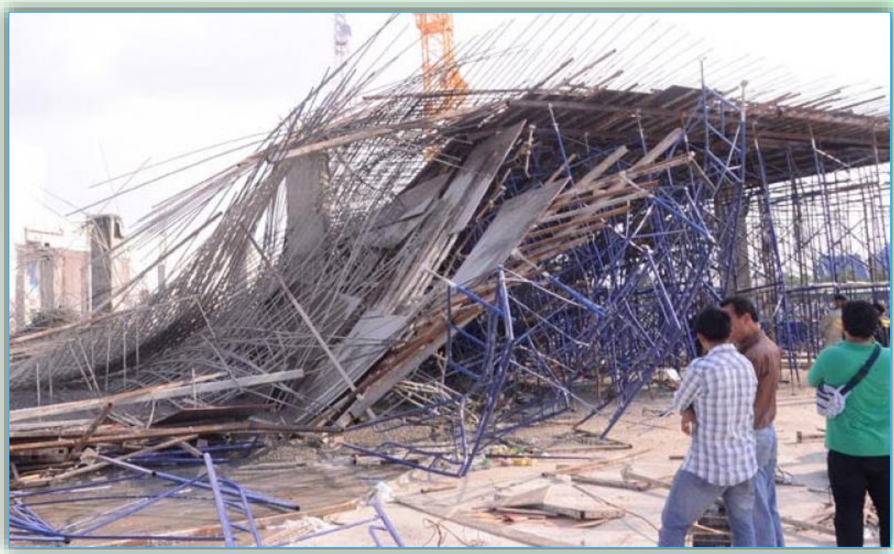
การพังทลายของอาคารในขณะที่เทคอนกรีต
