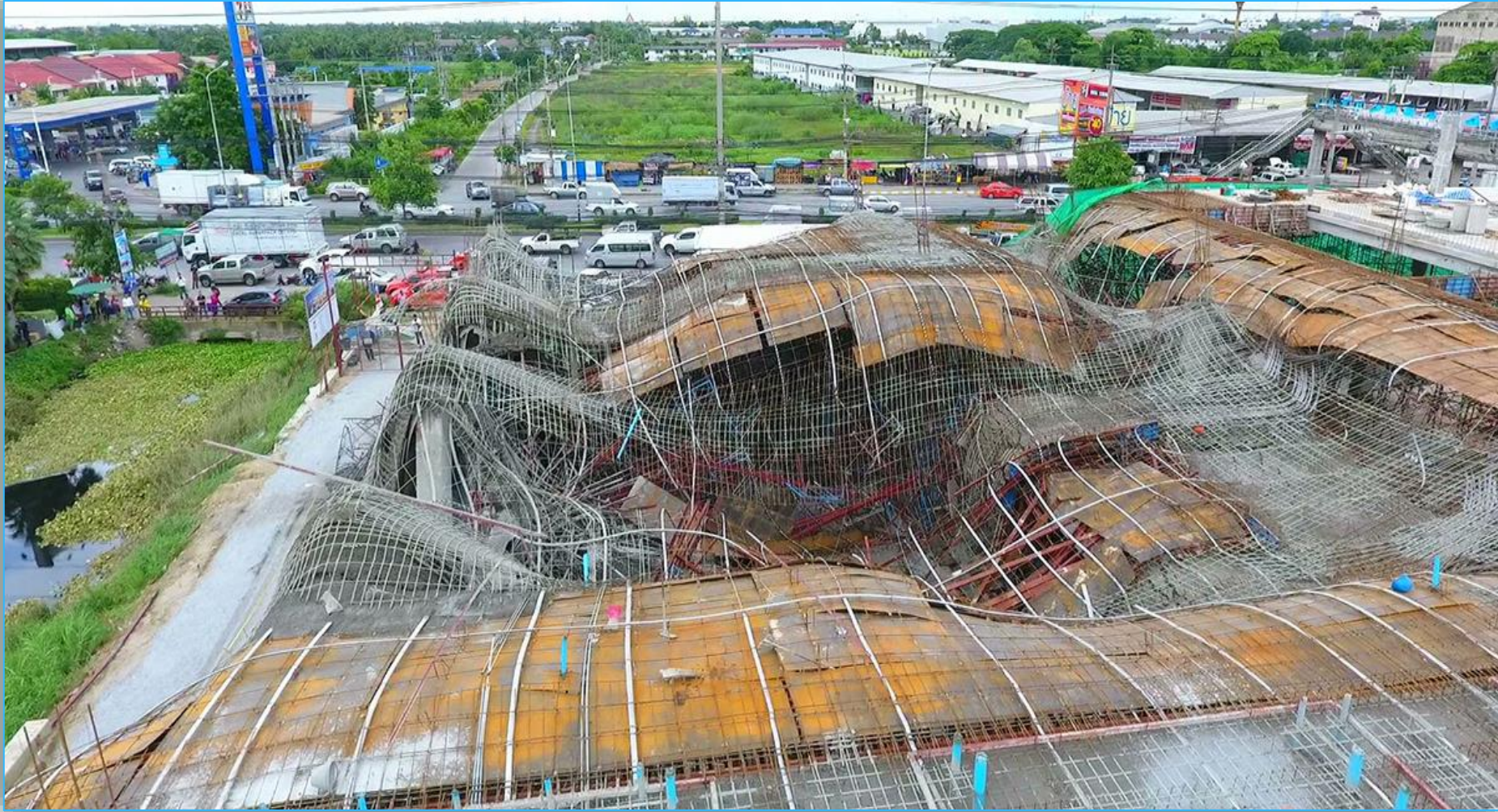
การพังทลายของอาคารในขณะที่เทคอนกรีต ปัญหาเกิดจากการตั้งนั่งร้านผิดวิธี
