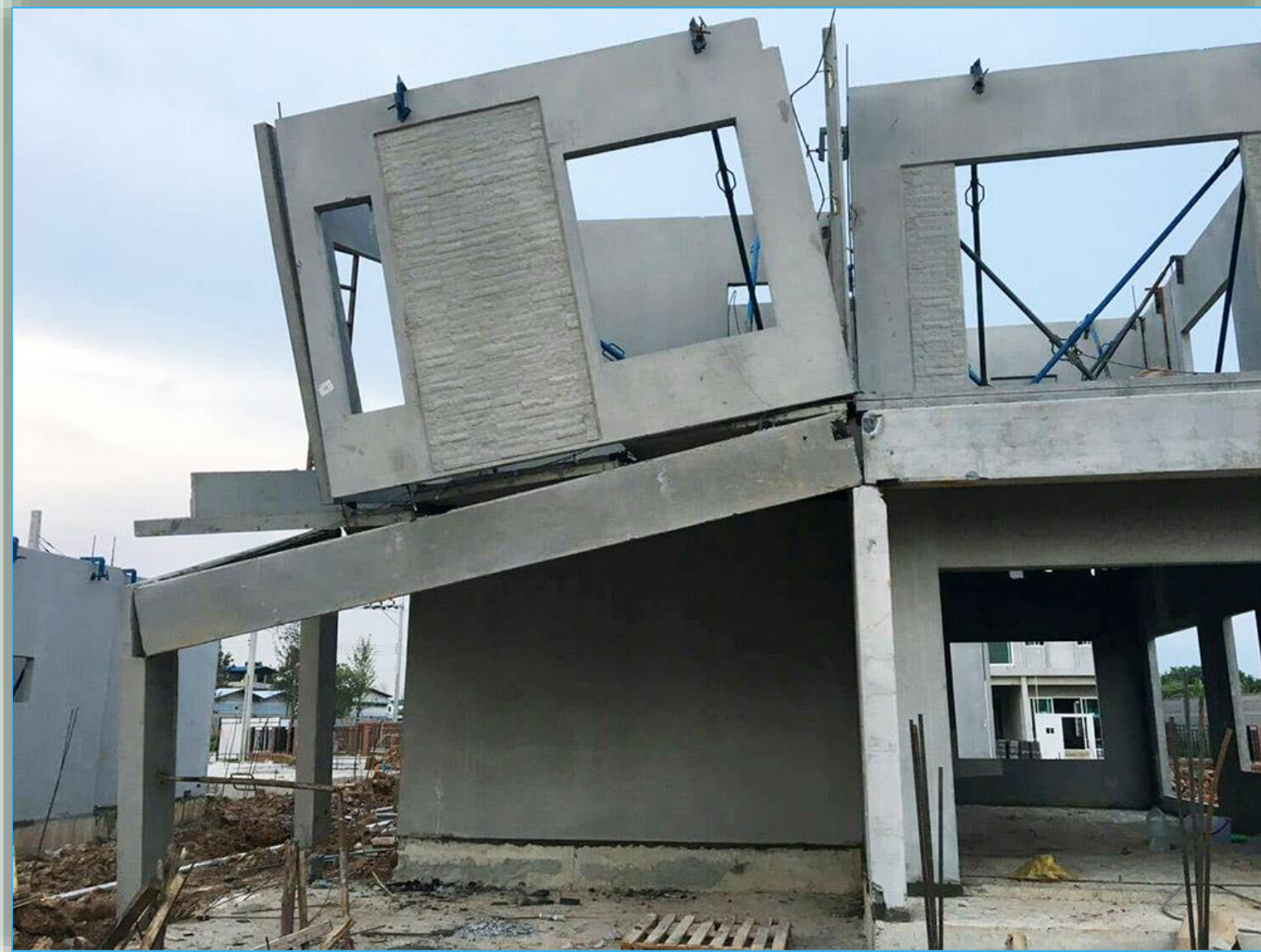
โครงสร้างแบบหล่อสำเร็จเกิดการทรุดตัว
