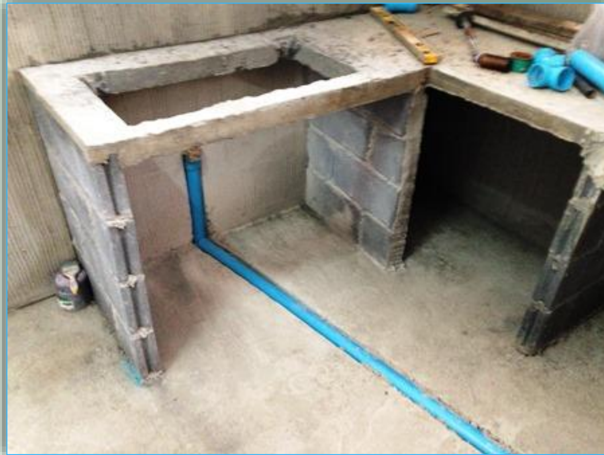
ก่อเคาน์เตอร์ครัว โดยการก่ออิฐบนพื้นเดิม
