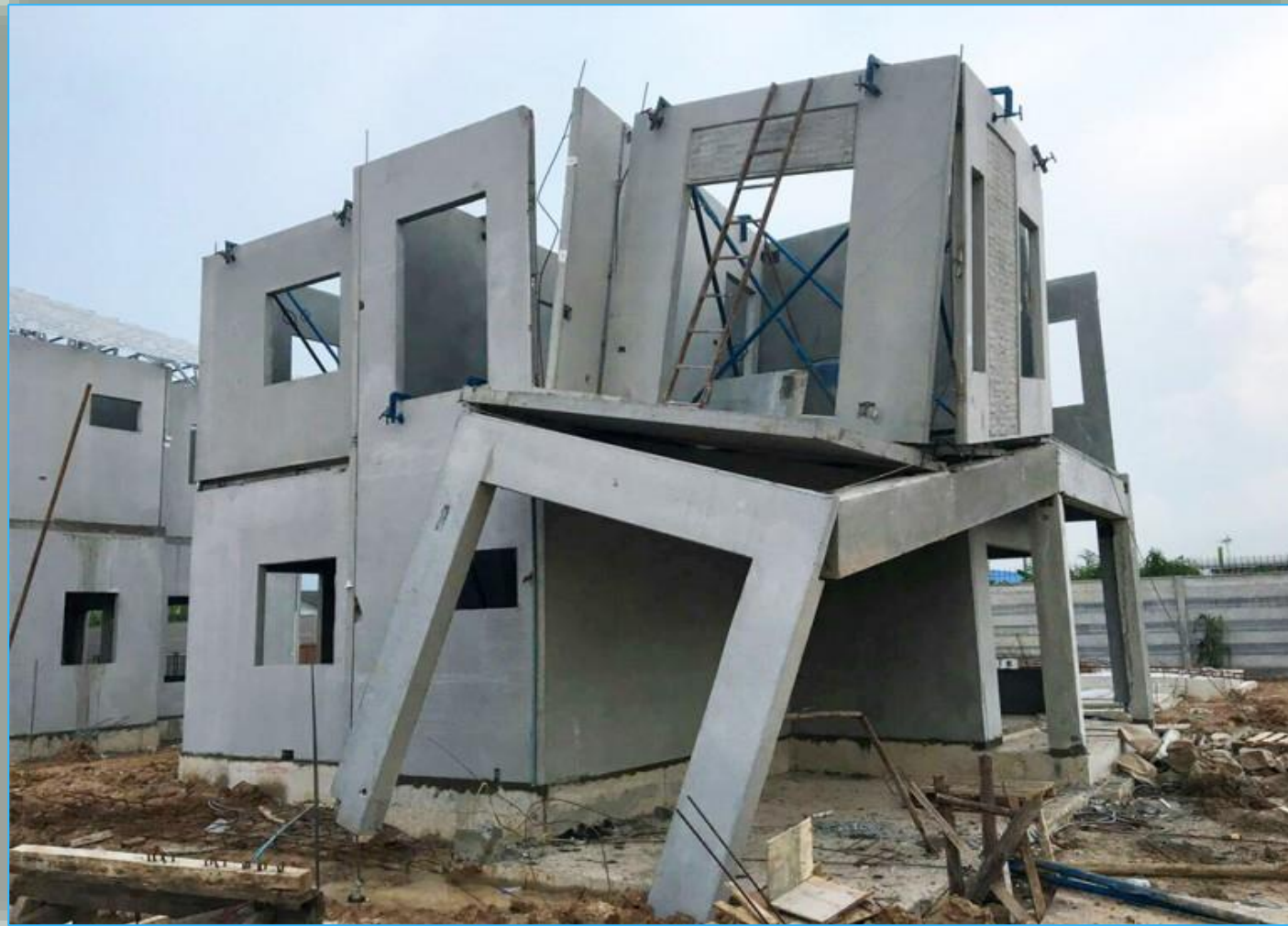
โครงสร้างแบบหล่อสำเร็จเกิดการทรุดตัว
