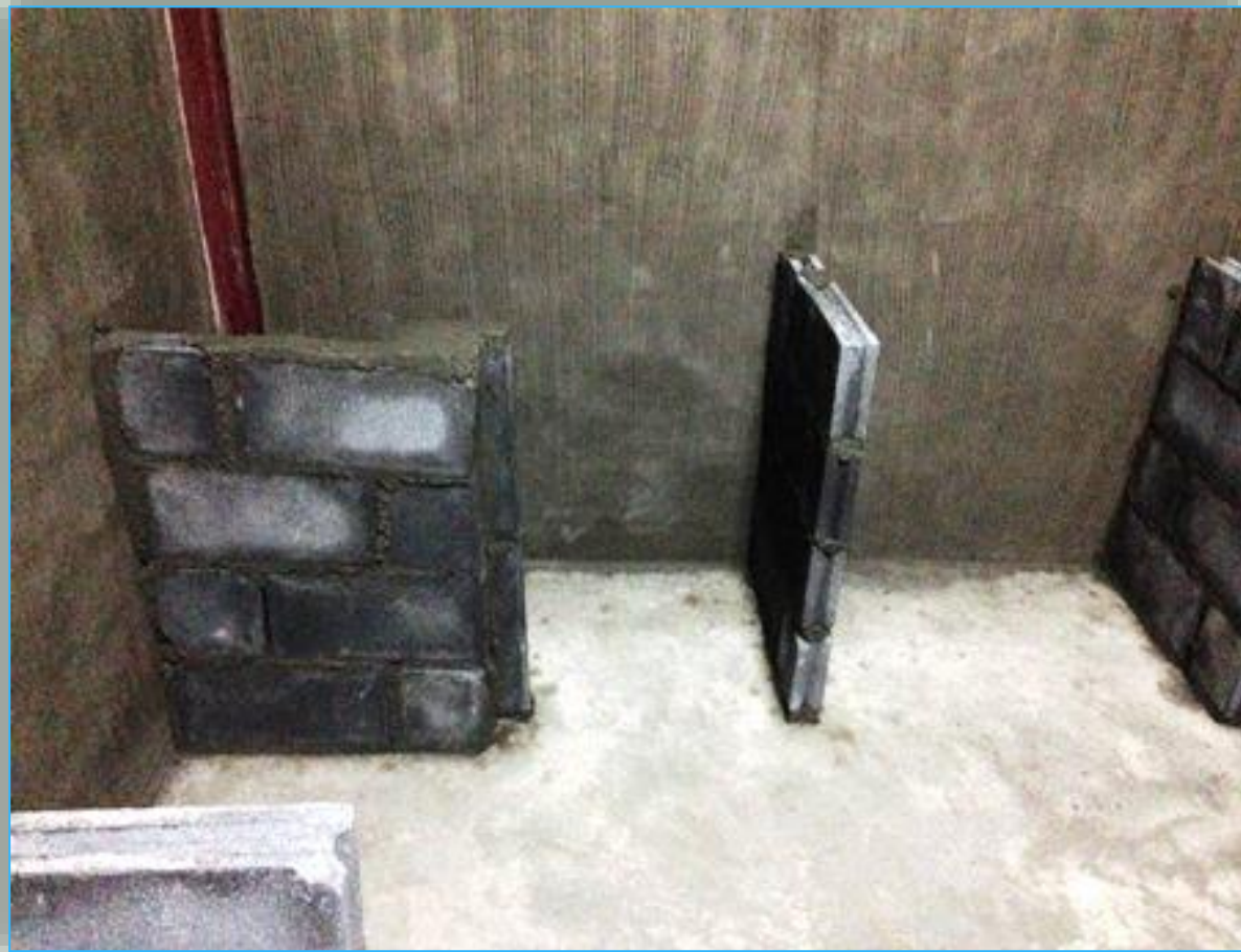
ก่อเคาน์เตอร์ครัว โดยการก่ออิฐบนพื้นเดิม
