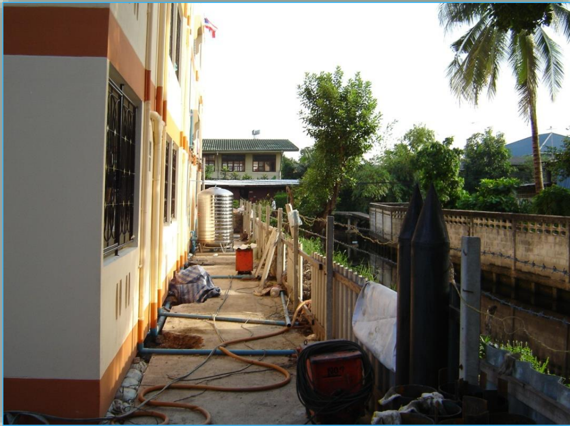
ก่อนยกปรับระดับอาคาร
