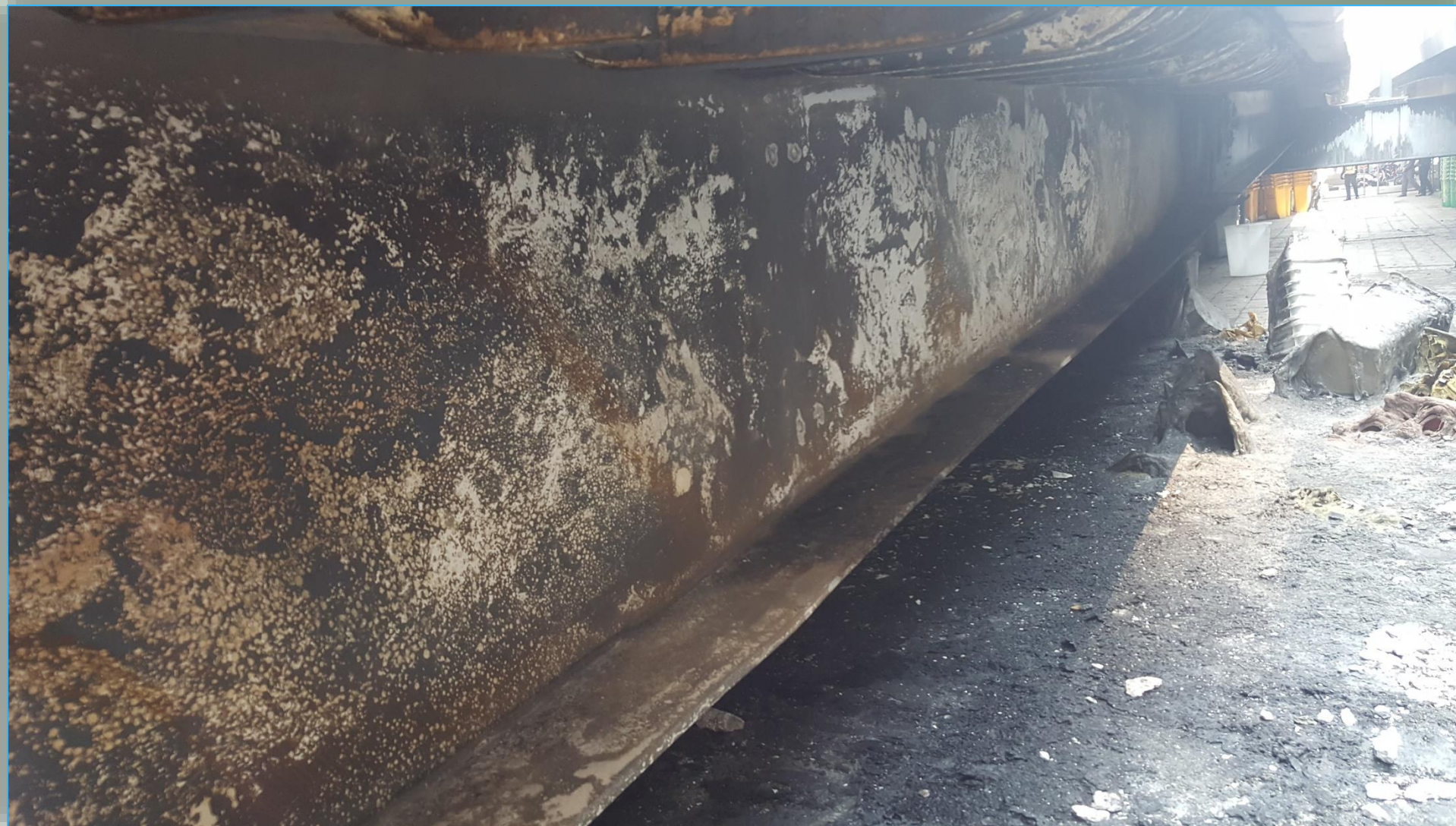
คานเหล็กโดนความร้อนสูง
