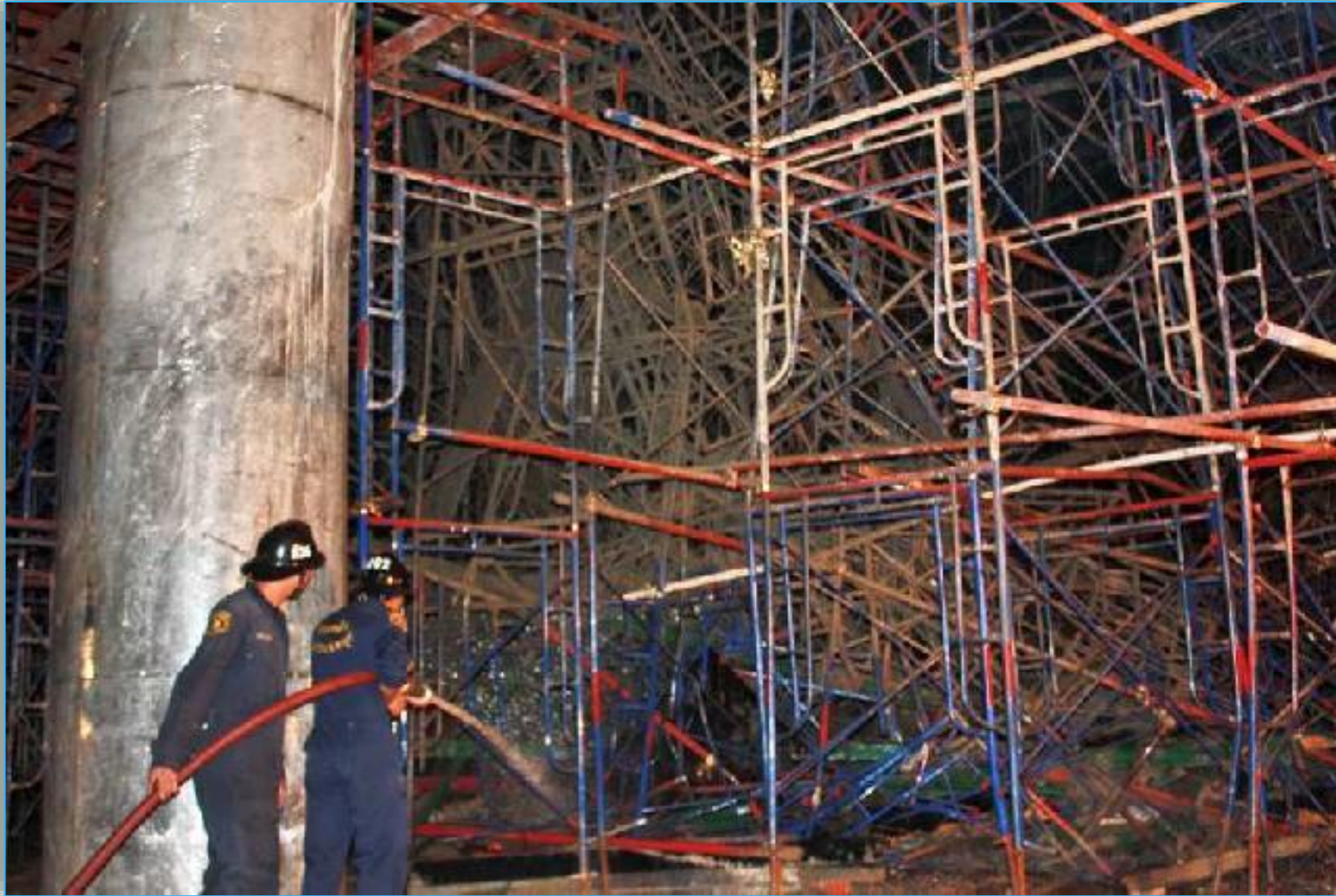
การพังทลายของอาคารในขณะที่เทคอนกรีต
