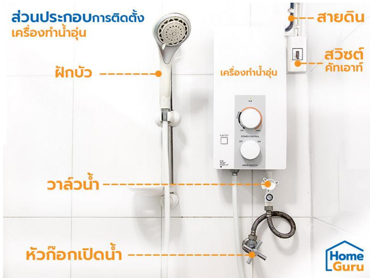
ภาพส่วนประกอบติดตั้งเครื่องทำน้ำอุ่น
