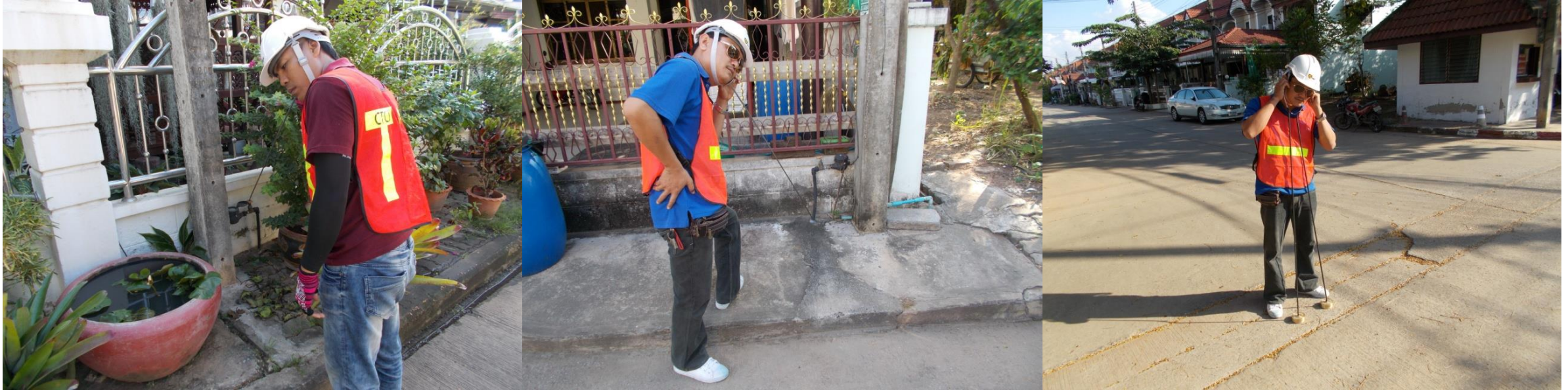
ภาพการใช้อุปกรณ์ฟังเสียงท่อแตกรั่วเพื่อระบุตำแหน่งจุดแตกรั่ว
