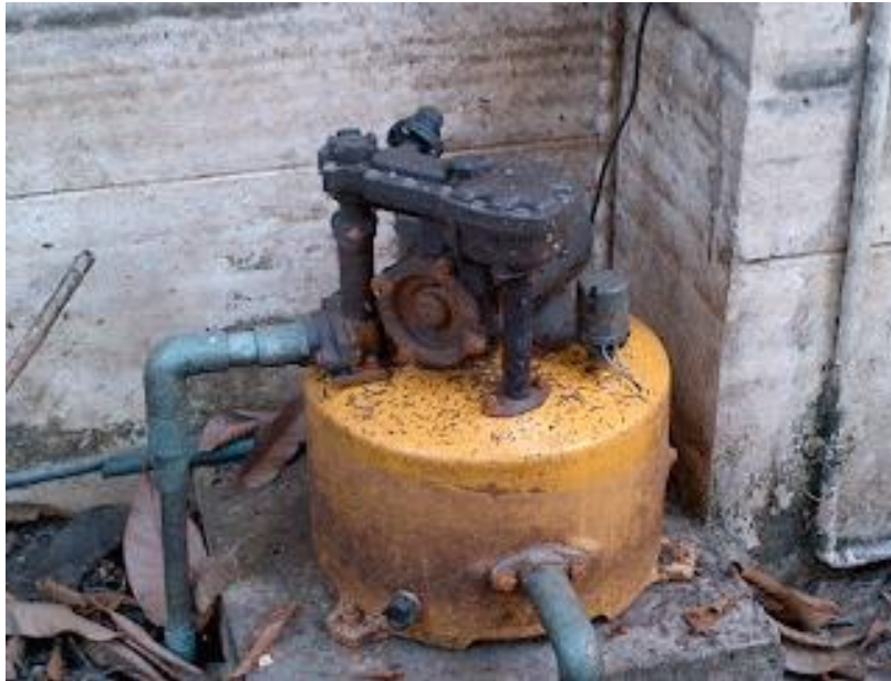
ภาพการตรวจสอบปั้มน้ำหลังน้ำท่วม
