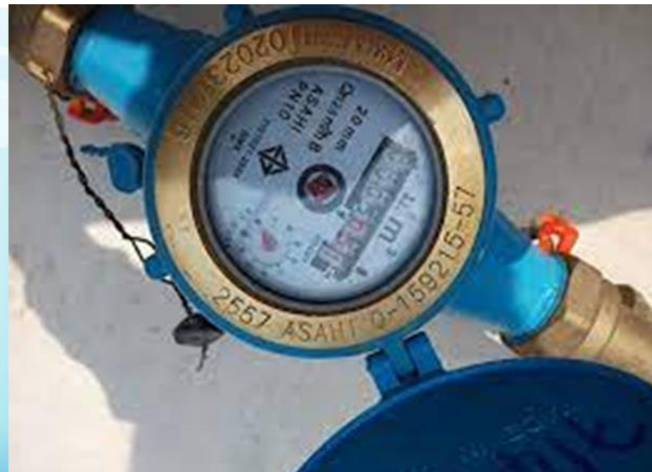
ภาพการตรวจสอบการรั่วไหลของท่อประปาโดยใช้มิเตอร์น้ำ
