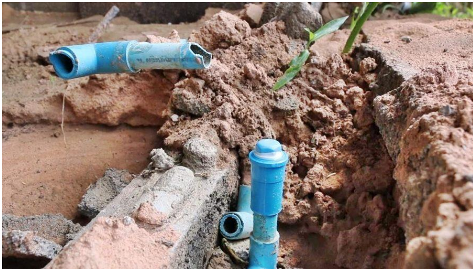
ภาพท่อแตกรั่วที่ได้รับผลกระทบจากน้ำท่วม
