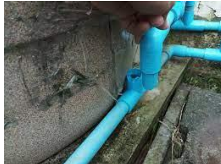
ภาพท่อแตกรั่วที่ได้รับผลกระทบจากน้ำท่วม
