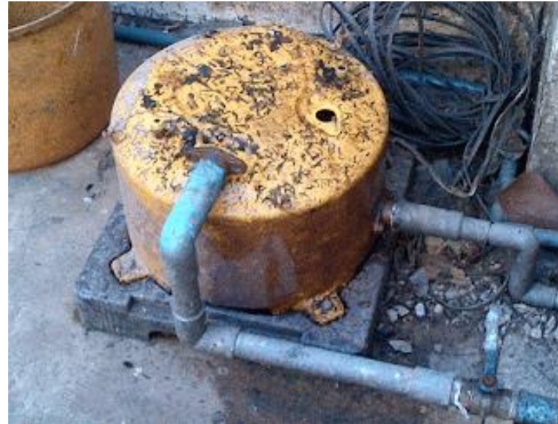
ภาพการตรวจสอบปั้มน้ำหลังน้ำท่วม
