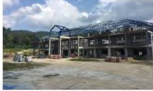
10. งานโครงหลังคา
