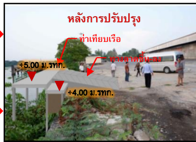
ก่อสร้างค้ำริมแม่น้ำทำหน้าที่เป็นค้ำป้องกันน้ำท่วมและท่าเทียบเรือขนส่งสินค้า
