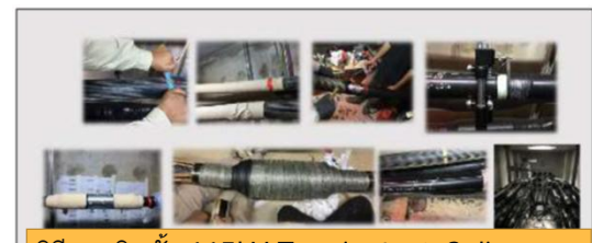
วิธีการติดตั้ง 115kV Terminator & Splices
