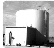
3. ที่เก็บน้ำสำรอง (Water Tank)
