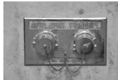
5. หัวรับน้ำดับเพลิง (Fire Department Connection)
