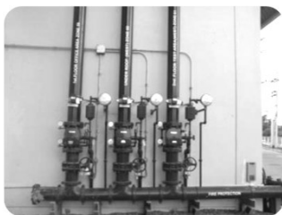
1. ท่อยืน (Riser / Stand pipe)
