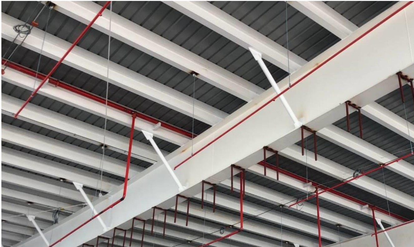
รูปโครงหลังคาหลักที่เสริม knee bracing
