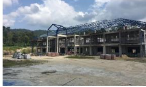
10. งานโครงหลังคา
