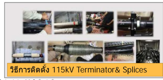
วิธีการติดตั้ง 115kV Terminator & Splices
