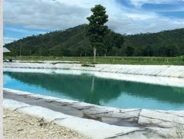
งานปูพื้นบ่อน้ำ
