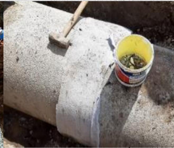
งานพันท่อระบายน้ำ
