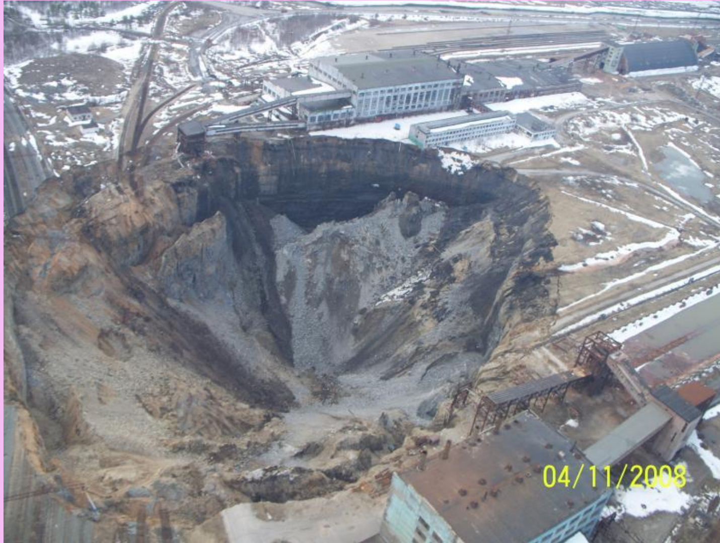
หลุมยุบหมายเลข 2 ภาพเมื่อ เดือนเมษายนปี 2008 วัดขนาดด้านบนได้ 385X270 เมตร ที่ก้นหลุมมี ขนาด 330X 230 เมตร ที่มา: ru.wikipedia.org .
