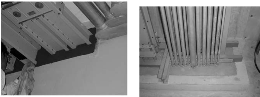
สายไฟฟ้าและการติดตั้งใช้งาน ... ลือชัย ทองนิล
