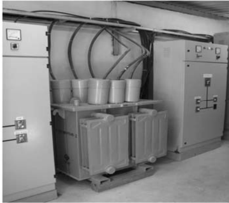
สายไฟฟ้าและการติดตั้งใช้งาน ... ลือชัย ทองนิล
