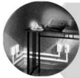
ช่องเดินสายอโลหะบนพื้นผิว
