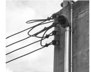
สายไฟฟ้าและการติดตั้งใช้งาน ... ลือชัย ทองนิล
