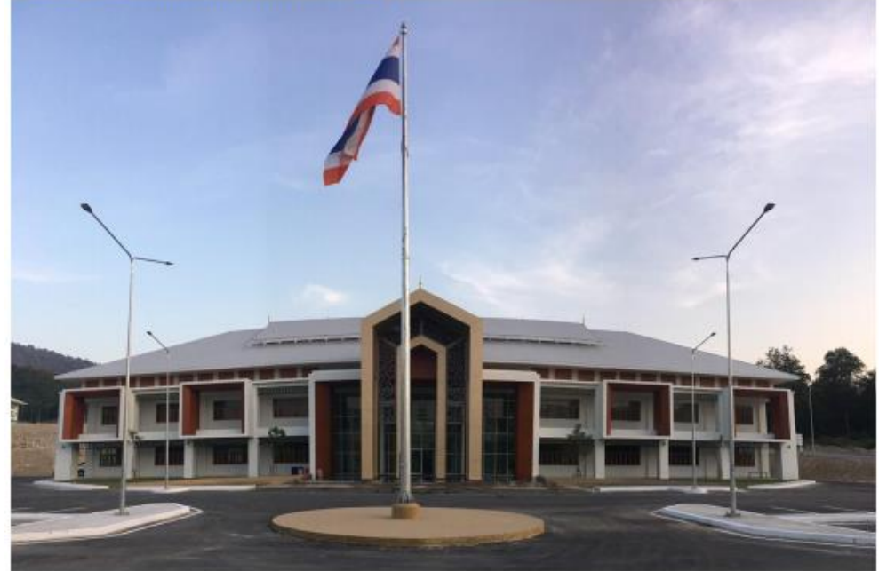
18. อาคารสำนักงานศุลกากรเสร็จสมบูรณ์
