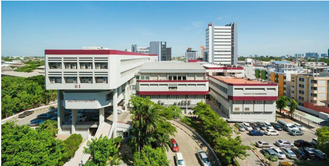
ภาพที่ 3 อาคารสำนักคณบดีคณะวิศวกรรมศาสตร์อาคารเรียนรวม อาคาร 81
