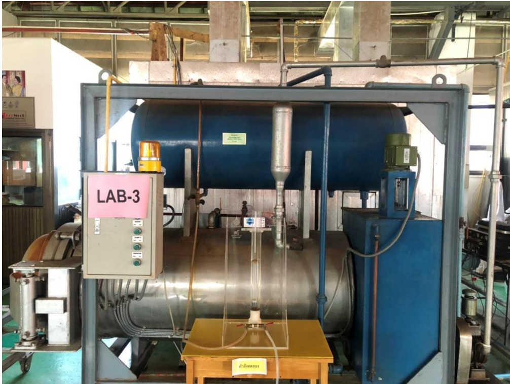
ชุด Boiler (มีอยู่ที่อาคารเครื่องมือวิทยาศาสตร์และเทคโนโลยี 2)
