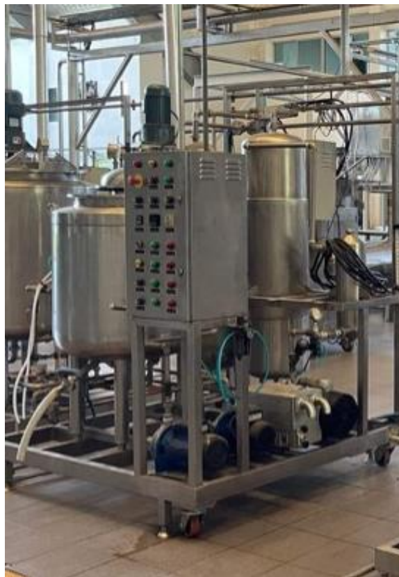
เครื่องทำระเหย แบบ Shell & Tube Heat Exchanger
