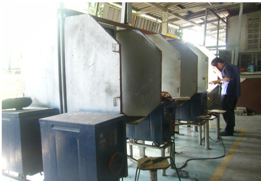
รูปที่ 8 ปฏิบัติการงานเชื่อมไฟฟ้า (Electrical welding operations)
