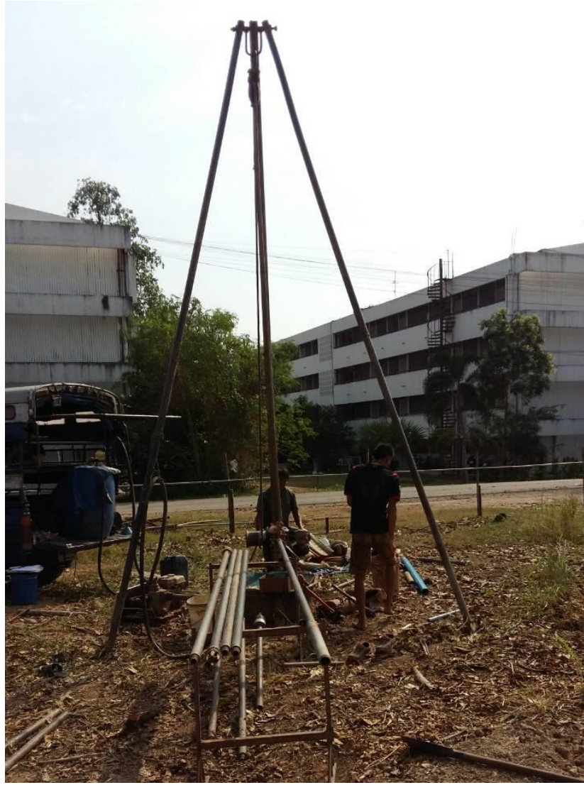
รูปที่ 1.2.1.13 เครื่องมือเจาะสำรวจดิน (สามารถเก็บตัวอย่างดินทั้งแบบไม่ถูกรบกวนและแบบถูกรบกวนได้ และสามารถทดสอบ หา SPT ในสนามได้)
