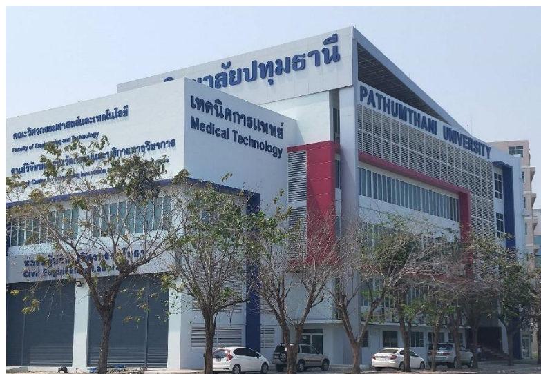
รูปที่ 4.2.2 อาคารเรียนคณะวิศวกรรมศาสตร์และเทคโนโลยี (หลังใหม่)
