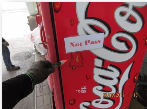
ตรวจเช็คด้วย Voltage detector พบว่ามีไฟรั่ว
