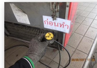
ภาพก่อนทำการแก้ไขของเต้าเสียบ ที่ขากราวด์ชำรุด
