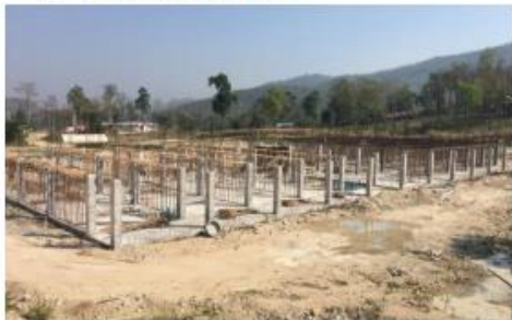
6. งานเสารับพื้นที่ 2
