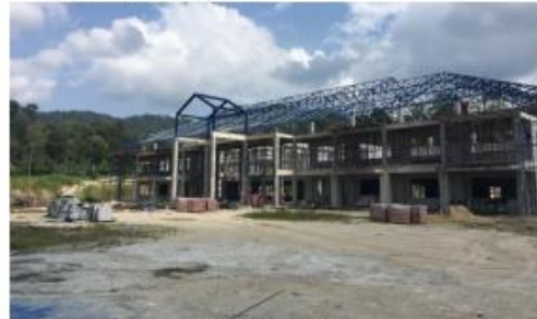
10. งานโครงหลังคา
