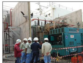
ติดตั้ง Generator
