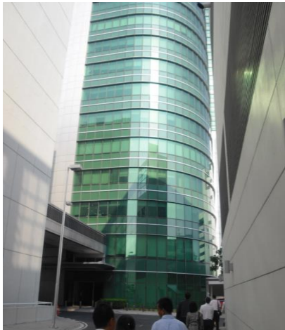
รูปที่ 101 ผนังด้านนอกเป็น curtain wall กระฉก
