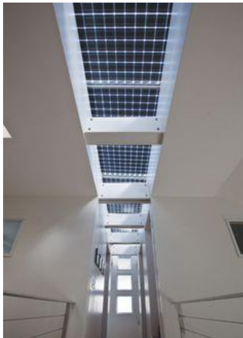
รูปที่ 118 การใช้แผงเซลล์แสงอาทิตย์ชนิดกระจก (PV glass)
