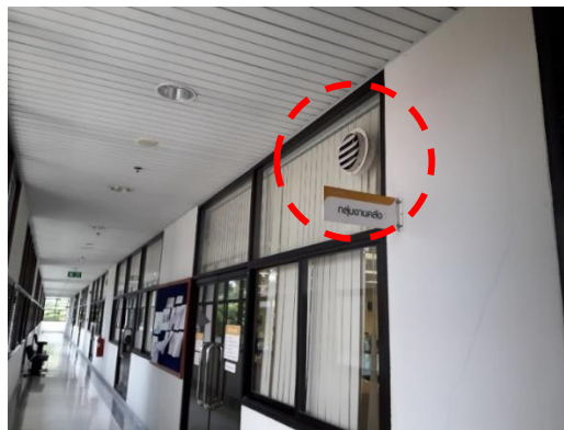
รูปที่ 81 ตำแหน่งพัดลมระบายอากาศบริเวณทางเข้าสำนักงานของแต่ละชั้น
