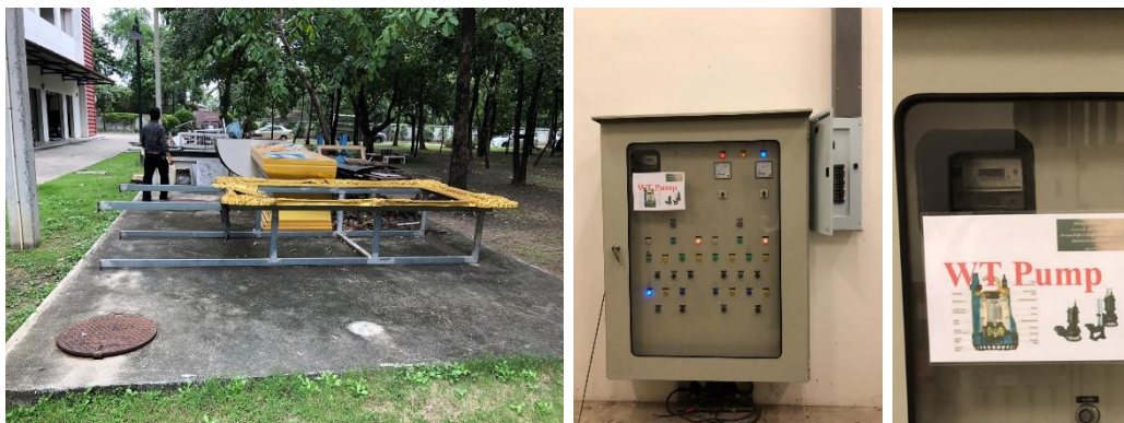
รูปที่ 91 มาตรวัดไฟฟ้าที่ใช้กับระบบบำบัดน้ำเสียของอาคารสำนักงาน ก.พ.
