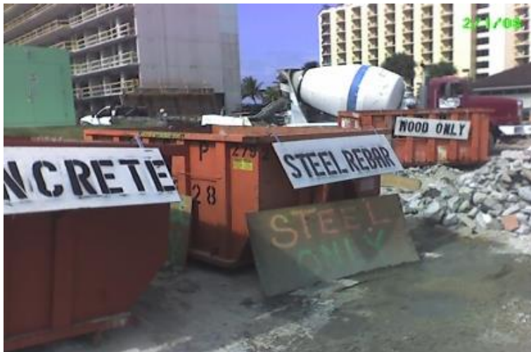
รูปที่ 89 การคัดแยกขยะในสถานที่ก่อสร้าง
