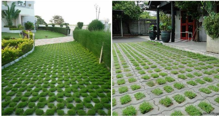
รูปที่ 11 การใช้บล็อกหญ้าเพื่อลดความร้อนของพื้นที่ลาดแข็ง
