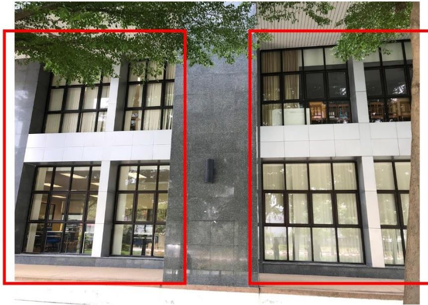
รูปที่ 35 ผนังหน้าอาคารชั้น 1 และ 2 คือ ผนังก่ออิฐมวลเบาด้านนอกบุแผ่นอะลูมิเนียมคอมโพสิต
