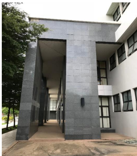
รูปที่ 36 ผนังตกแต่ง แผงบังแดด ด้านหน้าอาคารบริเวณชั้น 1 และ 2
