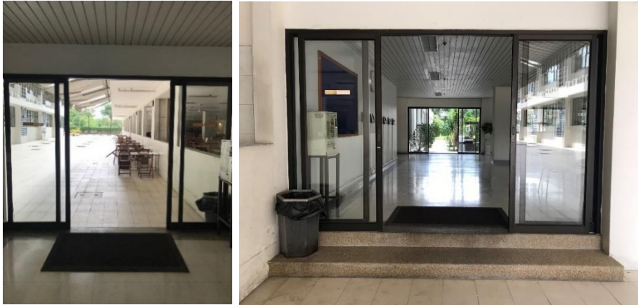
รูปที่ 51 พรหมเช็ดเท้าประตูทางเข้าอาคารหลักและรอง ชั้น 1 (หมายเลข 2, 3)
