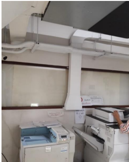
รูปที่ 73 ตัวอย่างพัดลมดูดระบายอากาศสำหรับเครื่องถ่ายเอกสาร
