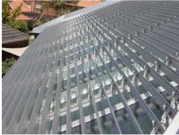
รูปที่ 117 การใช้อุปกรณ์บังแดดที่ด้านนอกอาคารเพื่อลดความร้อนจากช่องแสงหลังคา
