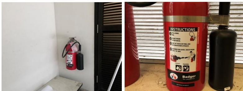
รูปที่ 94 ถังดับเพลิงมือถือชนิดก๊าซคาร์บอนไดออกไซด์ (CO 2 )
