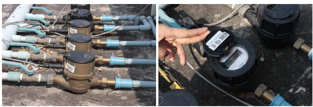
รูปที่ 81 ตัวอย่างการติดตั้งมาตรวัดน้ำย่อยแบบ digital แยกการใช้น้ำรายประเภท
