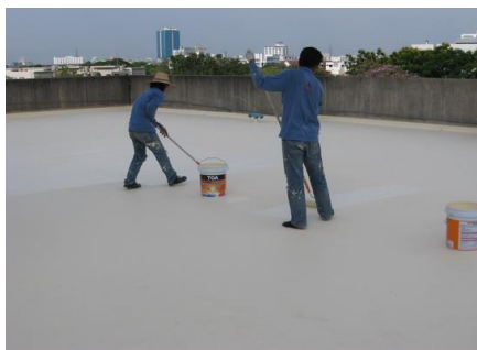
รูปที่ 113 การปรับปรุงโดยใช้ ceramic coating ทาบนหลังคา
