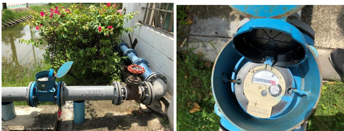
รูปที่ 92 มาตรวัดน้ำประจำอาคารสำนักงาน ก.พ.
