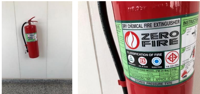
รูปที่ 93 ถังดับเพลิงมือถือชนิดผงเคมีแห้ง
