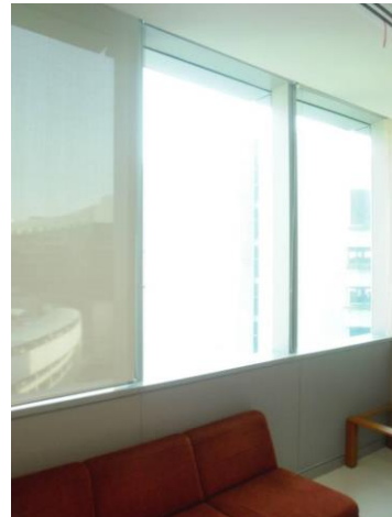
รูปที่ 102 ทำด้านหลังของผนังกระฉก ให้เป็นผนังทึบและใส่ฉนวน
