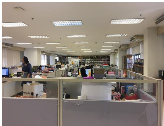
รูปที่ 54 สำนักงานใช้ฝ้ายิปซัมฉาบเรียบซึ่งมีค่า NRC ต่ำ
