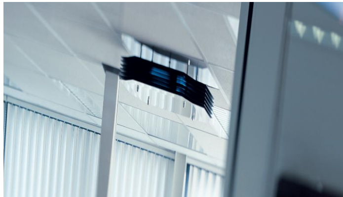
รูปที่ 61 การติดตั้งระบบ UVGI ชนิดติดตั้งที่เพดาน
