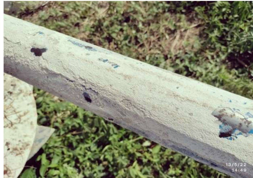
รูปตะกอนหินปูน (Scaling) เกาะบริเวณเครื่องเติมอากาศและท่อ
