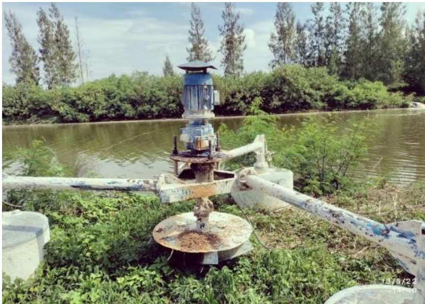
รูปตะกอนหินปูน (Scaling) เกาะบริเวณเครื่องเติมอากาศและท่อ
