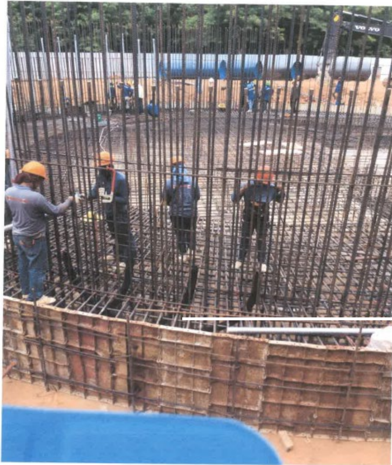
ภาพแสดงการติดตั้ง Loop Dead End ในส่วนพื้นของฐานนั่งคอนกรีต
