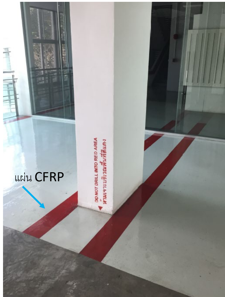
เสริม CFRP หลังพื้น
