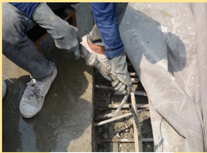
ภาพการอัดน้ำปูนเข้าท่อ Grout Vent
