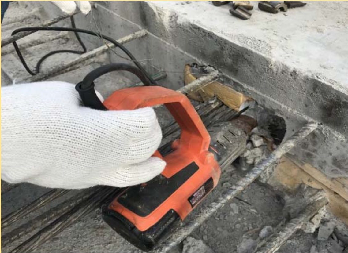
ภาพแสดงการใช้เครื่องเป่าลมร้อนช่วยในการแกะหัว Former ที่ทำจากโฟม
