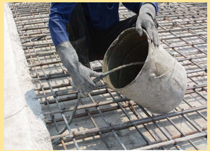
ภาพน้ำปูนไหลออกปลายท่ออีกด้าน
