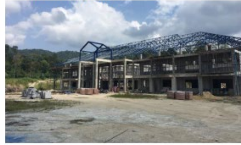
10. งานโครงหลังคา
