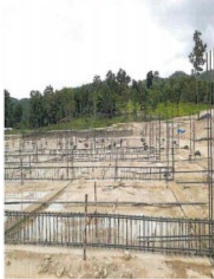
4. งานคานคอดิน ชั้นที่ 1
