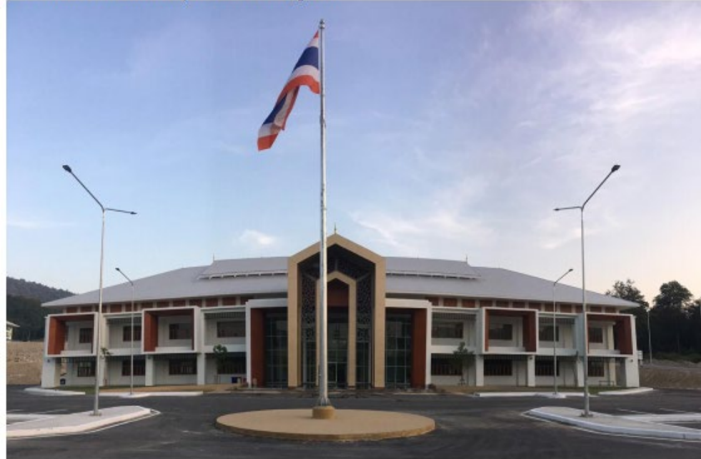
18. อาคารสำนักงานศุลกากรเสร็จสมบูรณ์
