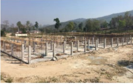
6. งานเสารับพื้นชั้นที่ 2
