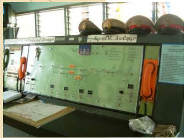
แผงควบคุม Relay Interlocking
