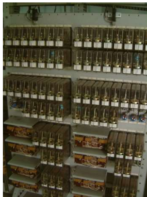
แผงควบคุม Relay Interlocking
