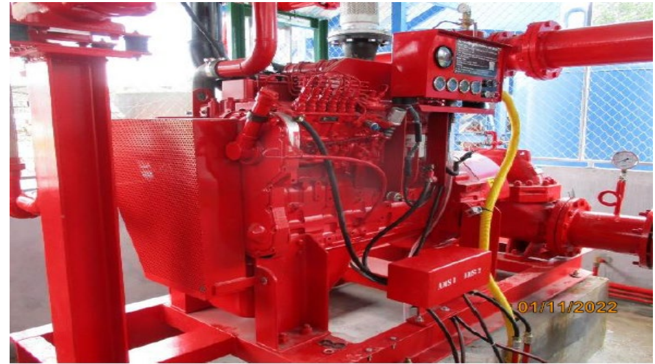
เครื่องยนต์ขับเคลื่อนเครื่องสูบน้ำดับเพลิง
