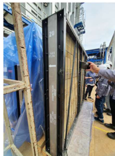
รูปที่ 13 Ammonia Injection Grid and Manifold
