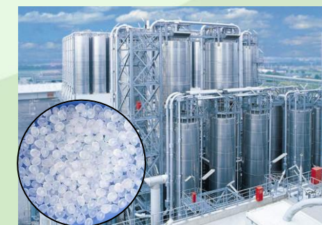
โรงงานปิโตรเคมี
