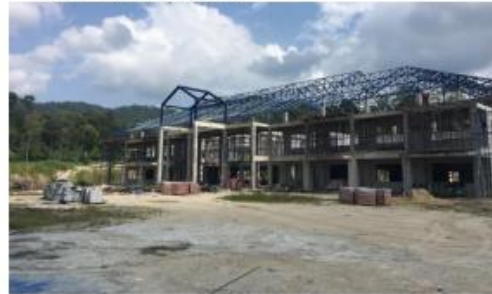
10. งานโครงหลังคา
