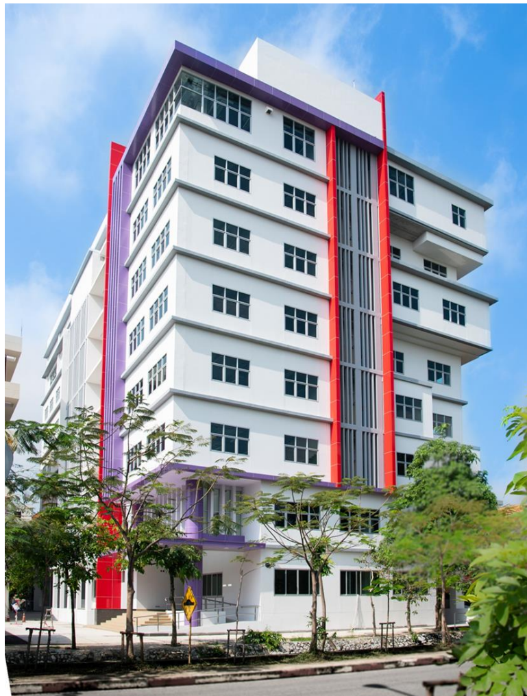
อาคารปฏิบัติการ 2 (SIIT Advanced Laboratory Building II)
