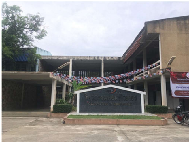
ภาพที่ 5.24 แสดงที่ตั้งอาคารวิศวกรรมคอมพิวเตอร์
