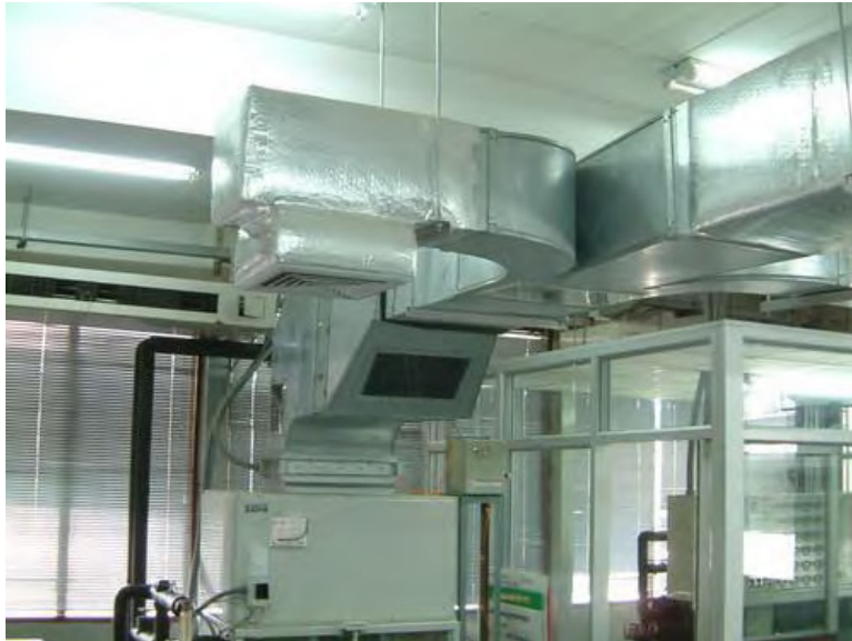
รูปที่ 85 Chilled-water Air Conditioning
