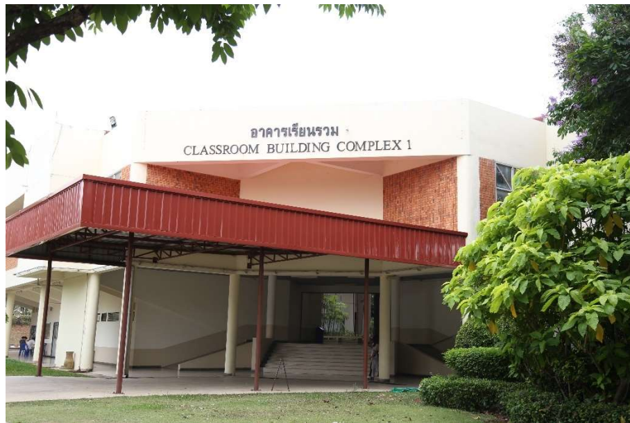
ที่ตั้งอาคารเรียนรวม 1
