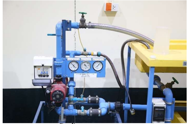
ชุดทดสอบปั้มน้ำต่อแบบอนุกรมและขนาน
