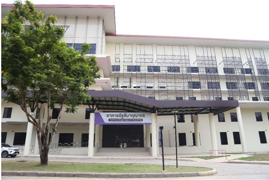
อาคารรัฐสภาคุณากร
