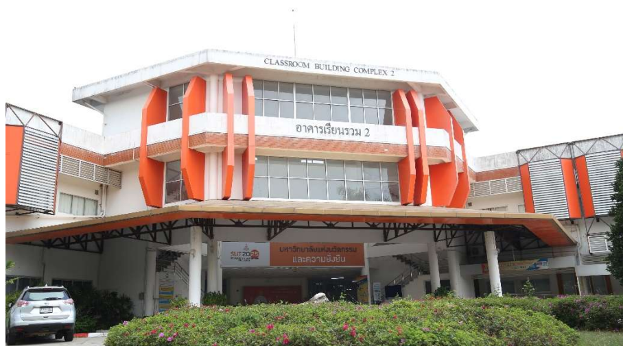
ที่ตั้งอาคารเรียนรวม 2
