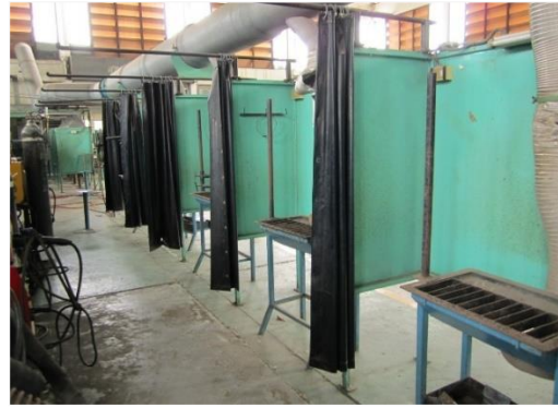
บริเวณปฏิบัติงานเชื่อมไฟฟ้า
