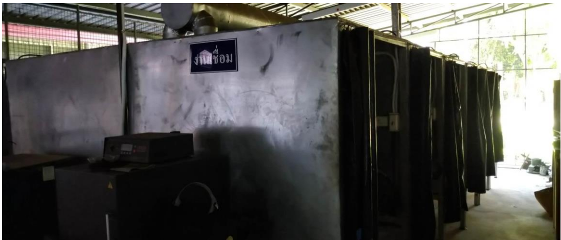
ภาพที่ 8 ตู้เชื่อมและเครื่องเชื่อม
