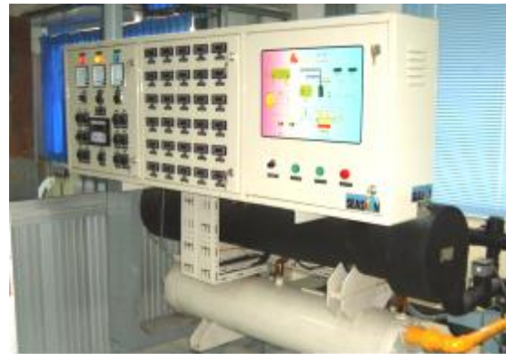
ภาพที่ 71 Water Chiller Unit
