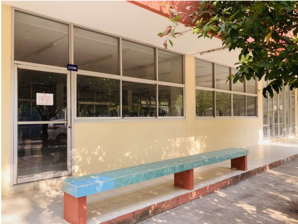
รูปที่ 9 ห้อง 13106 ปฏิบัติการวัสดุก่อสร้างและคอนกรีตเทคโนโลยี
