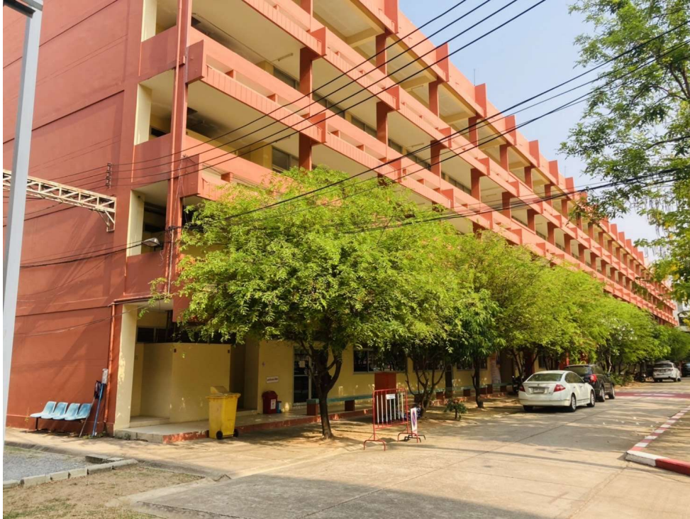
รูปที่ 1 อาคาร 13 อาคารปฏิบัติการวิศวกรรมโยธา (Civil Engineering Laboratory)
