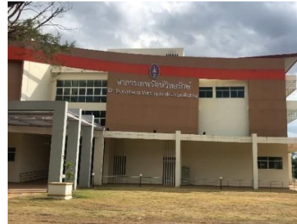
อาคารเทพรัตนวิทย์รักษ์อาคารเครื่องมือ 12 (F12)
