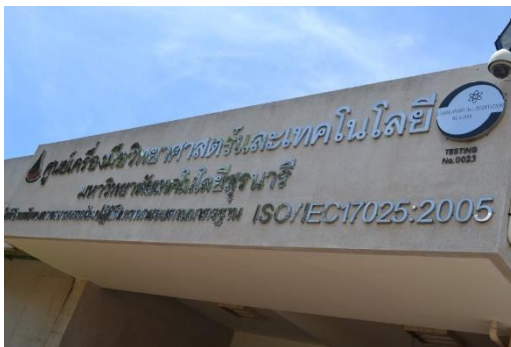
อาคารเครื่องมือ 1 (F1)
