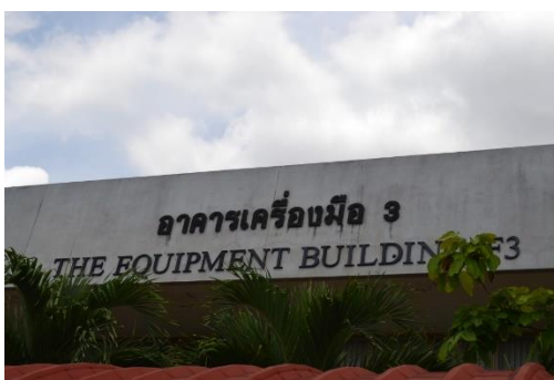
อาคารเครื่องมือ 3 (F3)
