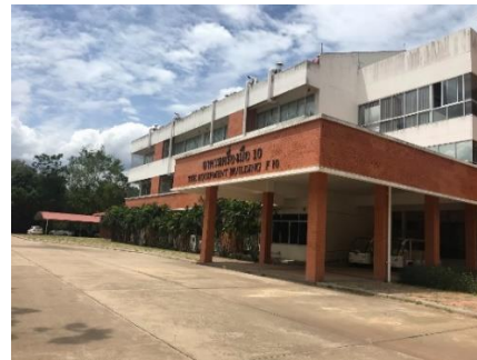
อาคารเครื่องมือ 10 (F10)
