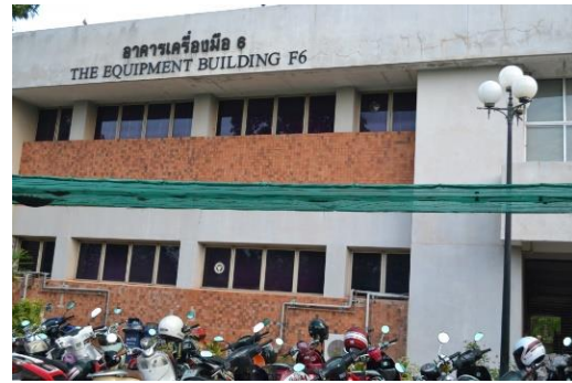
อาคารเครื่องมือ 6 (F6)
