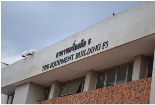
อาคารเครื่องมือ 5 (F5)
