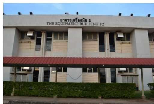
อาคารเครื่องมือ 2 (F2)
