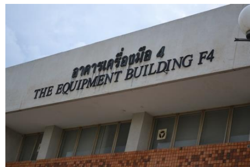
อาคารเครื่องมือ 4 (F4)
