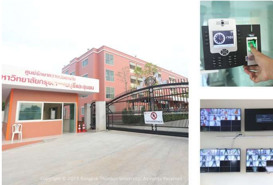
ภาพที่ 14 จุดรับแจ้งเหตุ และศูนย์ความปลอดภัยหอพักนักศึกษา
