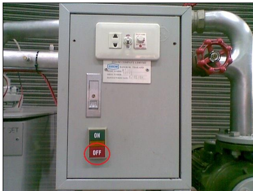
รูปที่ 28 การปิดเครื่องทดลองกังหัน
