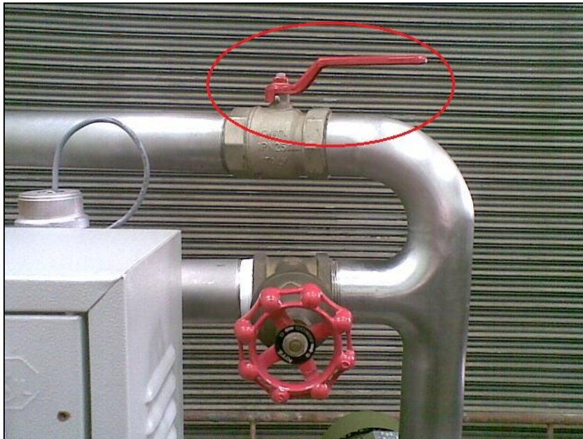
รูปที่ 26 การเปิดวาล์วท่อเบียง
