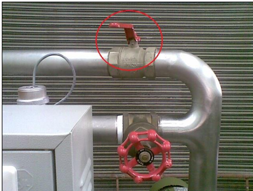
รูปที่ 12 การปิดวาล์วท่อเบี่ยง
