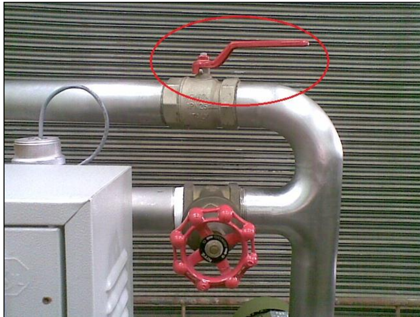
รูปที่ 43 การเปิดวาล์วท่อเบียง
