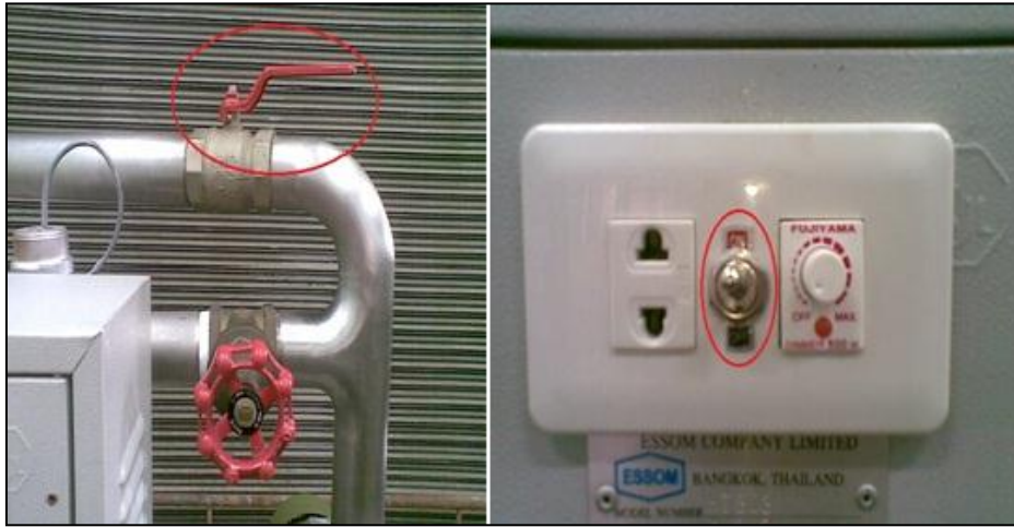
รูปที่ 36 การเปิดเครื่องกำเนิดไฟฟ้า
