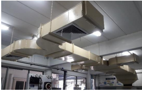
การทดสอบปรับแต่งลมและออกแบบท่อส่งลม
