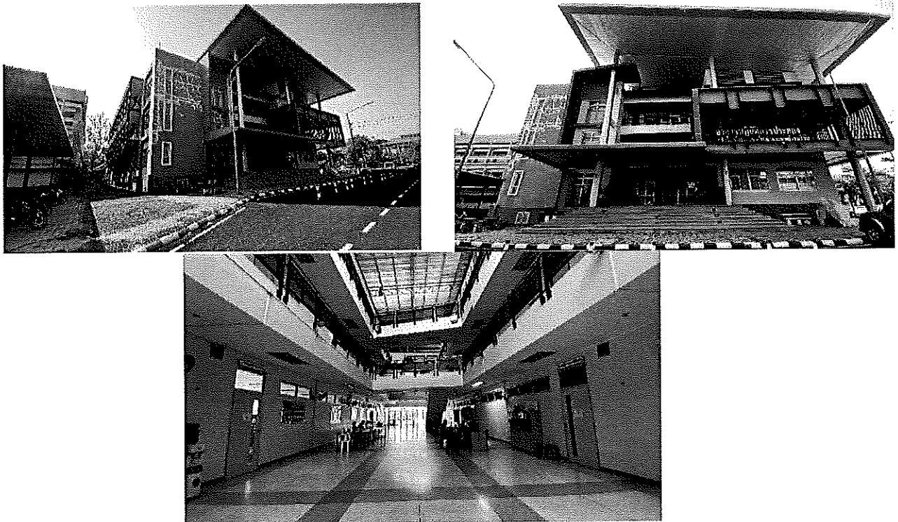
รูปที่ 5.1 รูปภายนอกและภายในชั้นที่ 1 อาคาร EN 7 เป็นอาคารปฏิบัติการทดลองและศูนย์วิจัยร่วม
